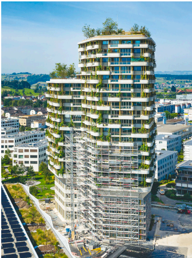
4 Gartenhochhaus «Aglaya», Suurstoffi, Rotkreuz
