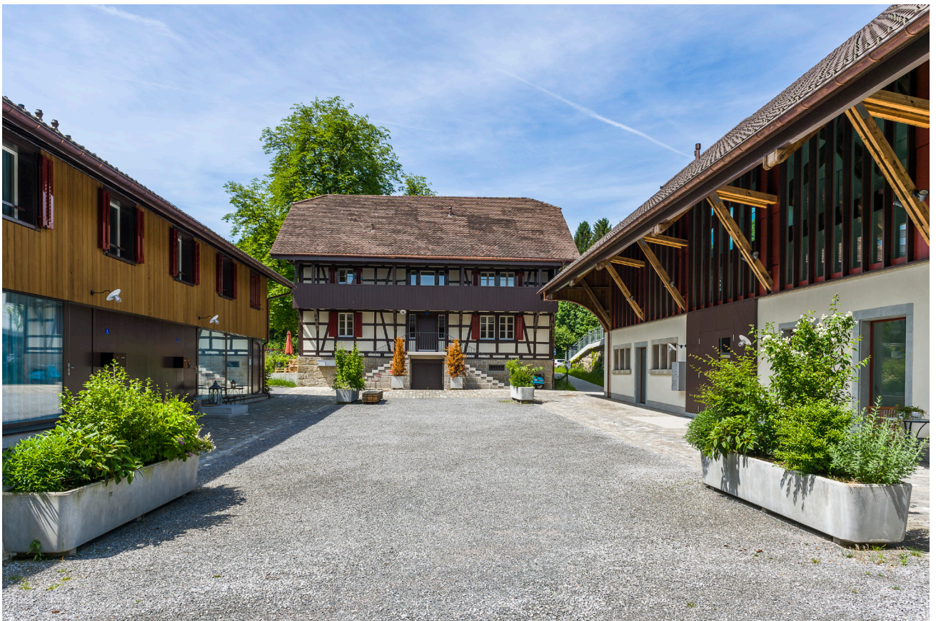
2 Wohnüberbauung Hammergut, Cham
