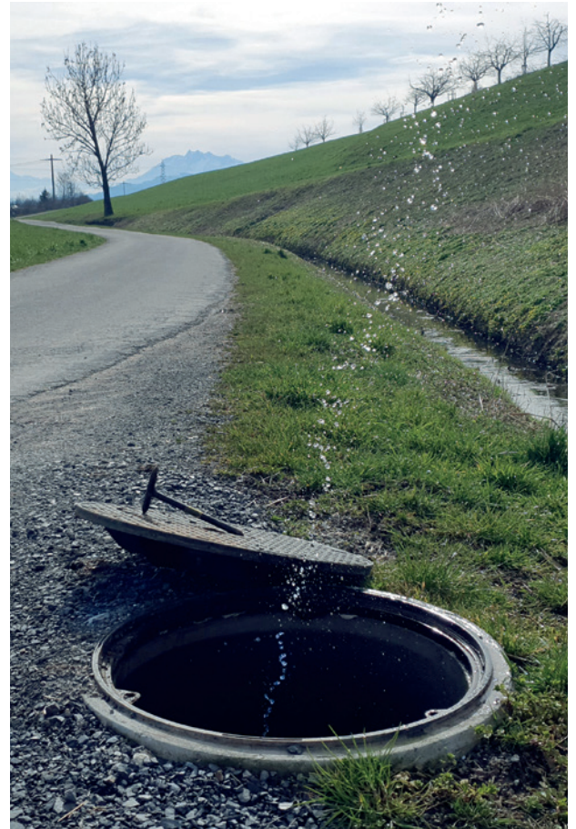
Unter artesischem Druck stehendes Tiefengrundwasser schießt in Baar aus einer Messstelle.
