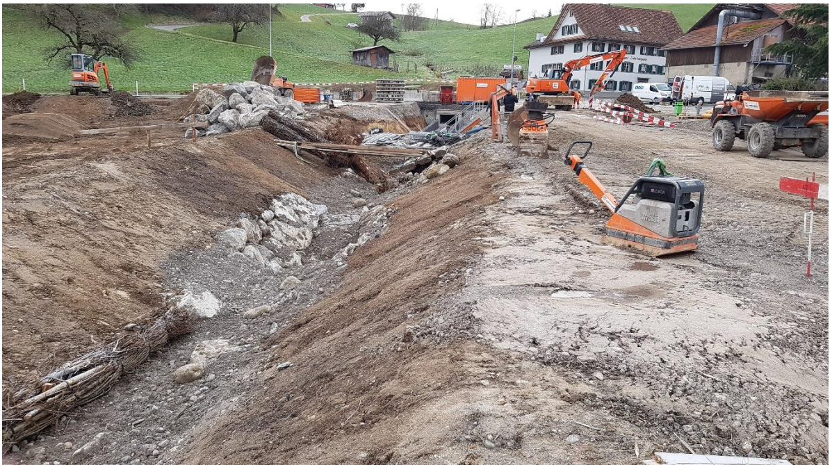
Der Hinterburgmülibach in Neuheim bekommt ein neues Bachbett.
