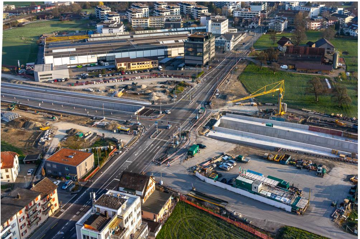
Luftaufnahme der Kreuzung Zugerstrasse/Südstrasse in Baar.
