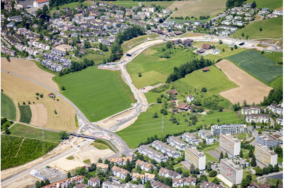
Luftaufnahme des östlichen Teils der Tangente Baar/Zug vom Installationsplatz Inwil (unten links) bis zum Margel (oben rechts), wo der Geissbühl Tunnel endet und der Anschluss an die Ägeristrasse erfolgt.
