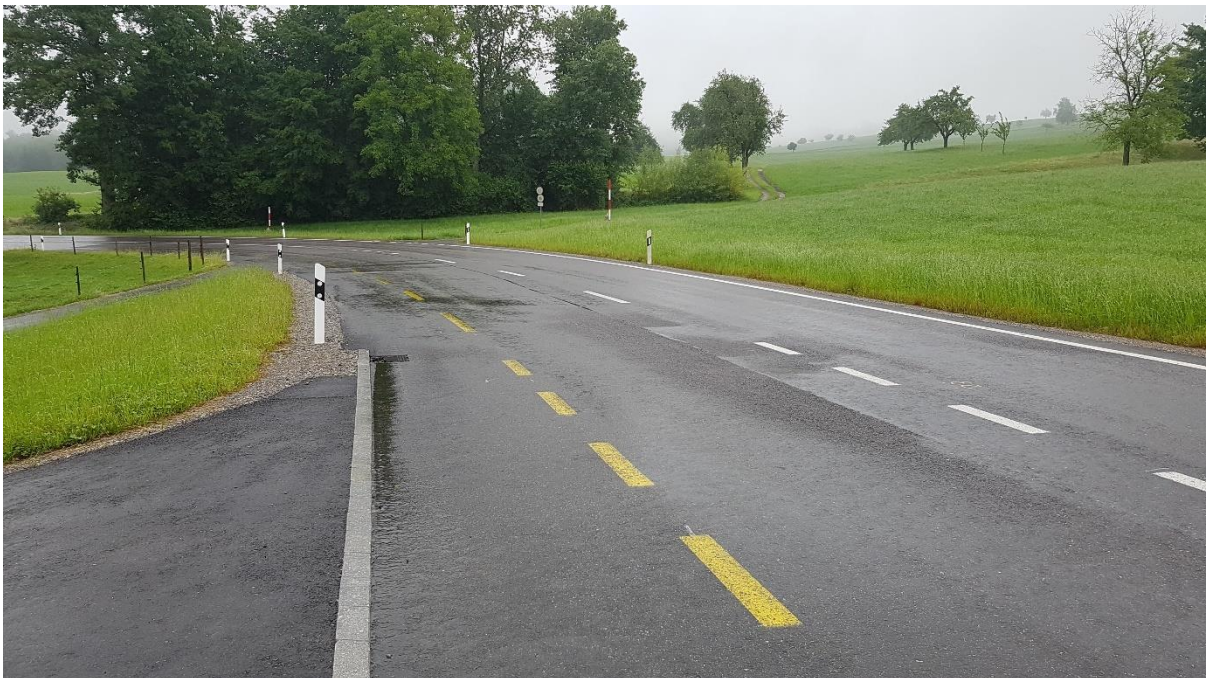
Die Ägerstrasse in Baar bekommt bald einen neuen Deckbelag.
