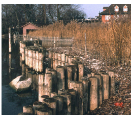
Wirkungsvoller Schutz durch Palisaden und Kiesschüttung
