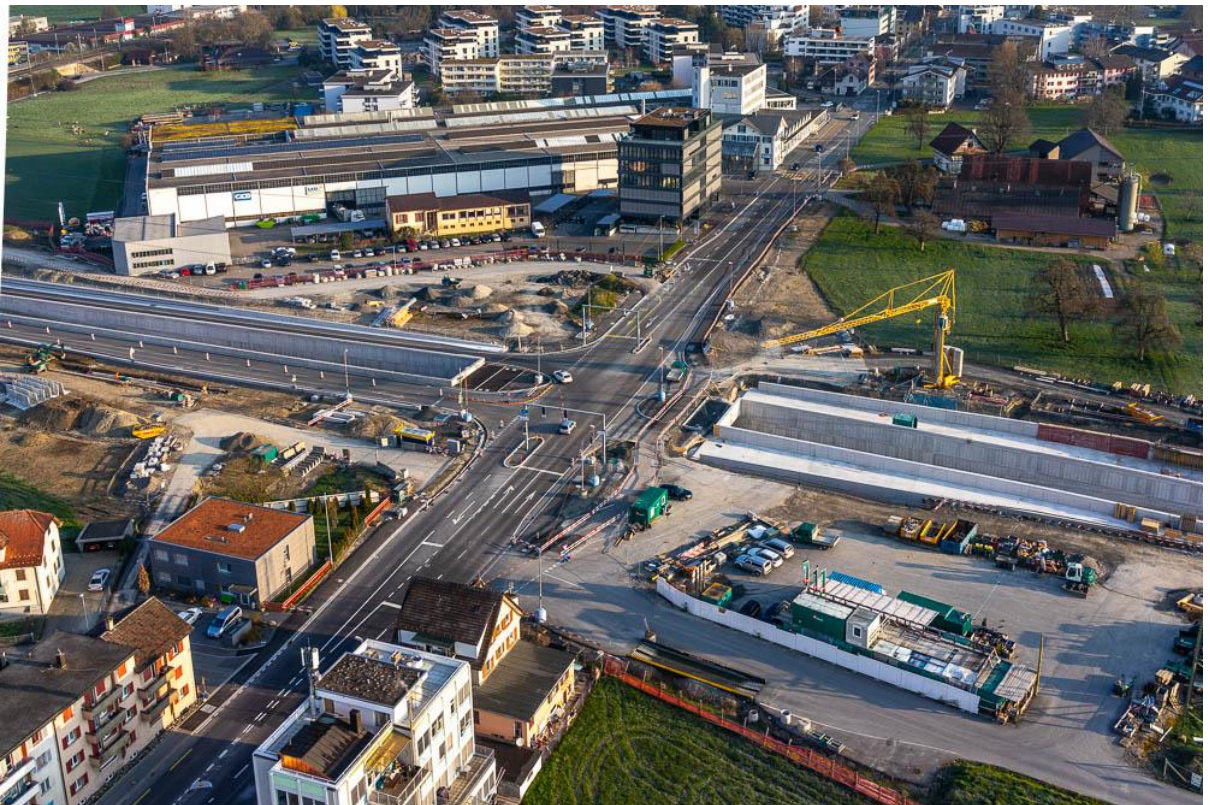
Luftaufnahme der Kreuzung Zugerstrasse/Südstrasse in Baar.
