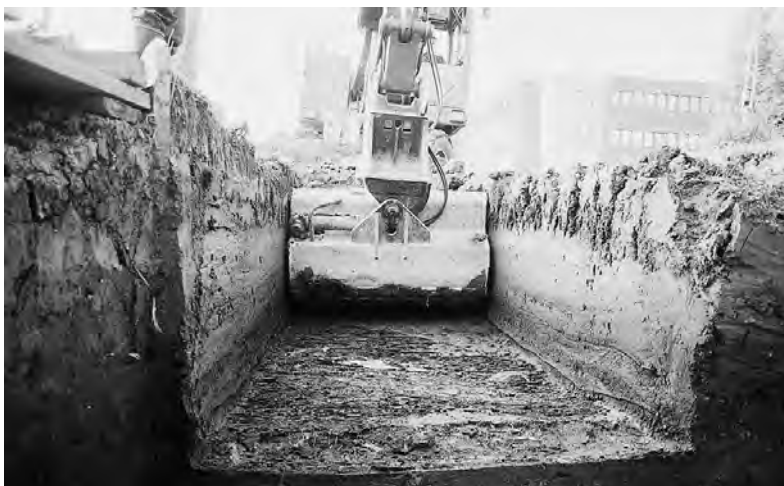
Abb. 8 Steinhausen-Chollerpark. Ein Sondierschnitt wird geöffnet: Die Baggerschaufel entfernt zügig die jüngeren Deckschichten über der obersten holzführenden Fundschicht.
