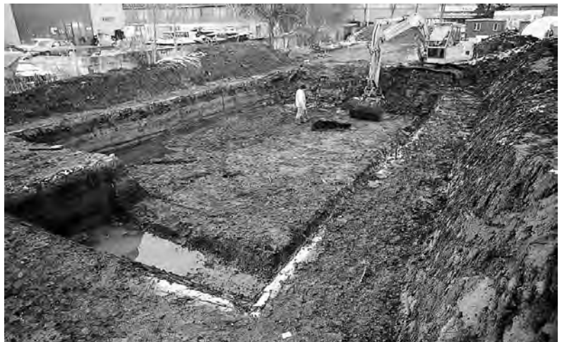
Abb. 14 Steinhausen-Chollerpark. Arbeitsaufnahme: Überwachung des maschinellen Baggeraushubes bis knapp über die fundführenden Holzschichten.
