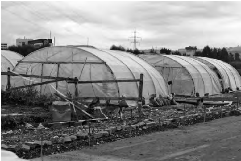
Abb. 17 Steinhausen-Sennweid, Rettungsgrabungen 1988–91. Um den Fortgang der Arbeiten bei jeder Witterung zu gewährleisten, wurden die Grabungsfelder mit Zelten überdacht.
