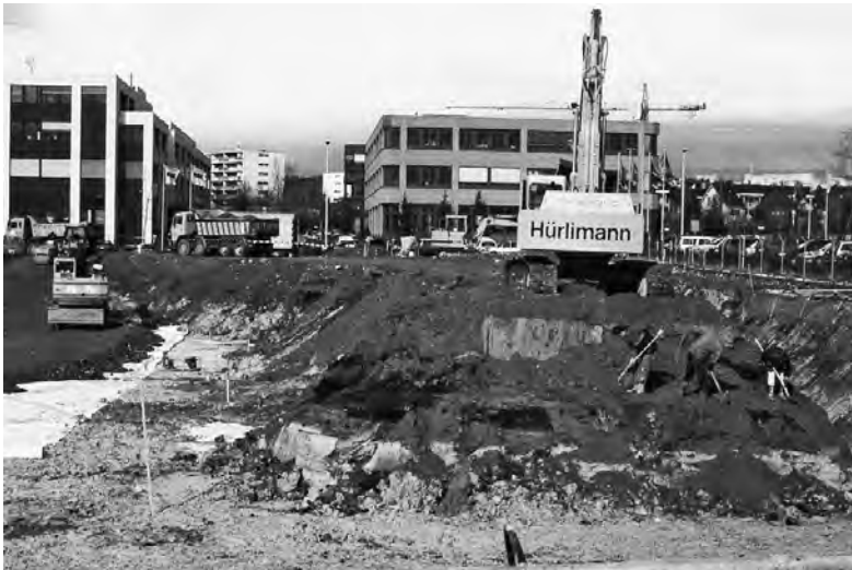
Abb. 20 Steinhausen-Sennweid, Rettungsgrabung Cosmetochem 1995. Arbeit vor der Baggerschaufel.
