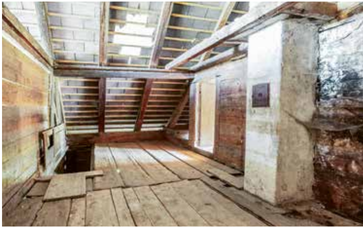
55 Morsche und faule Holzteile mussten sorgfältig entfernt und durch neue, formgleiche Balken ersetzt werden.
