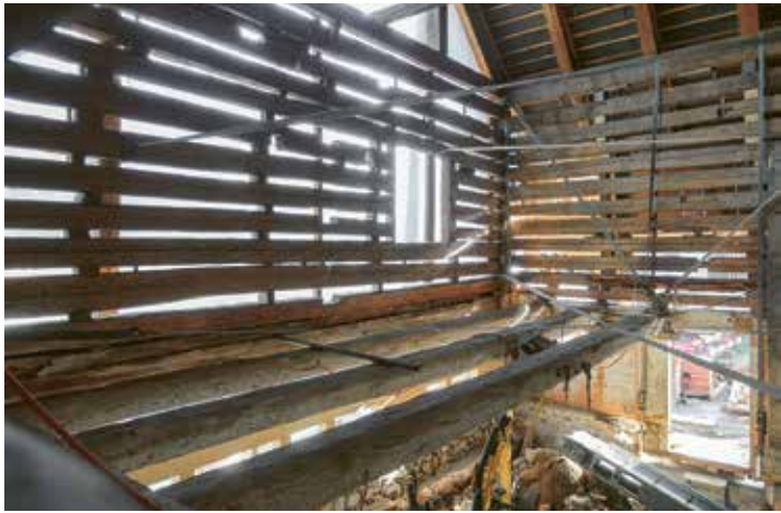
54 Eine Untersuchung ergab, dass die ältesten Balken aus der Zeit um 1620 stammen und die jüngsten um 1780.
