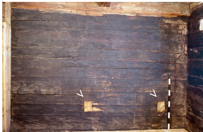
Abb. 261: Die Einschnitte zur Verankerung der beiden die Herdstelle überspannenden Balken in Haus Chammersbüel in Unterägeri.
