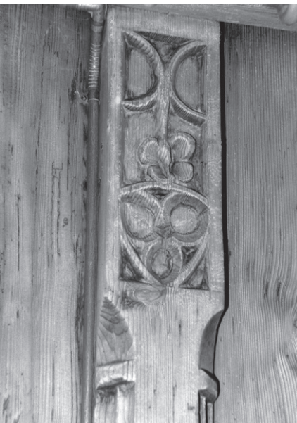
Abb. 115: Ausschnitt aus der mit Schnitzereien verzierten Bohlen-Balkendecke in der Stube von Haus Kirchmattgasse 1 in Oberägeri; diese Decke aus dem 16. Jahrhundert gilt als eine der schönsten im Kanton Zug.
