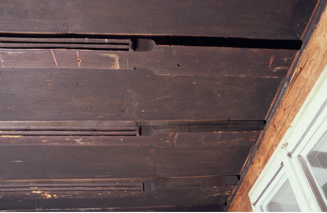
Abb. 114: Die Untersichten der Balken der Bohlen-Balkendecke in der Stube von Haus Hauptstrasse 16 in Menzingen (Kat. 6), 1687d, weisen beidseitig eine zweifache Kehlung auf; die Kehlung schliesst jeweils in einer durch Wulst abgesetzten Schmiege.
