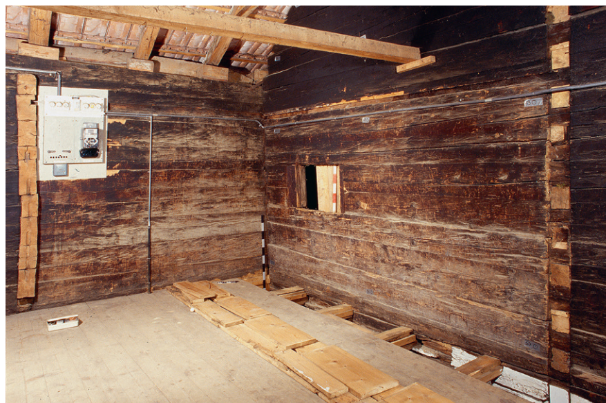
Abb. 228: Die Binnenwände der Eckkammer (2.3) im Haus Grubenstrasse 37 in Oberägeri waren komplett abgetragen worden. Die Dimensionen des Raumes konnten anhand von Verkämmungsnegativen der Wände und der Nuten/Falze zur Einbringung der Fussboden-/Deckenbohlen bestimmt werden.
