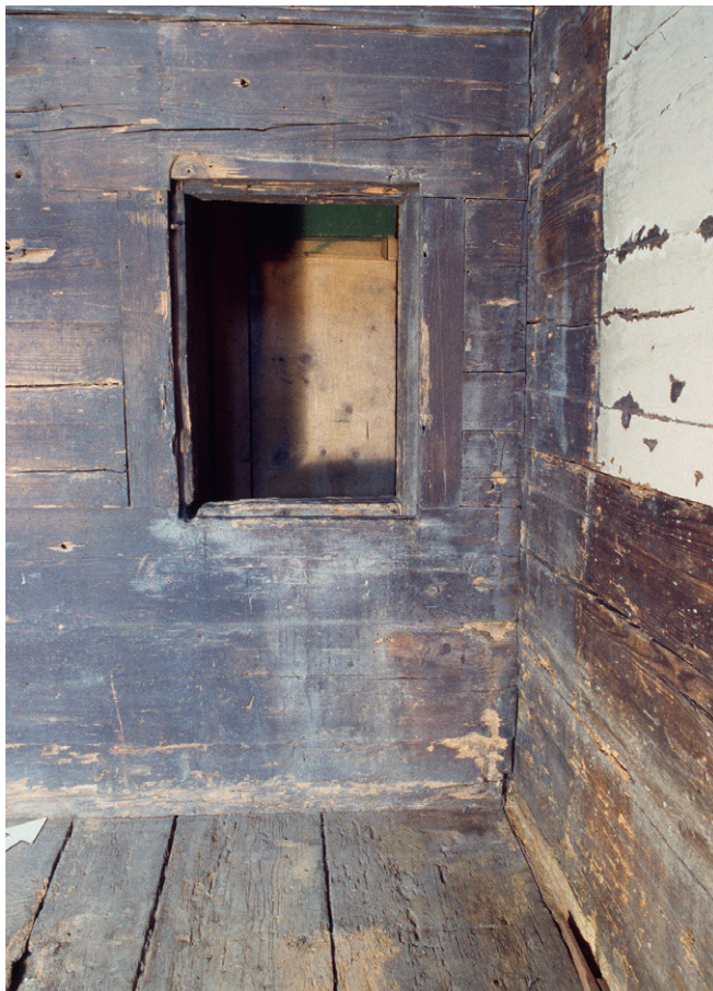
Abb. 37: Fensterartige Binnenwandöffnung in der Querwand von Haus Oberzittenbuch in Unterägeri (Kat. 17), 1555d; Ansicht aus der Stube.
