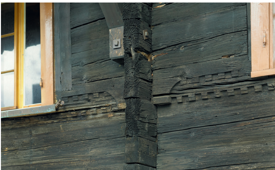
Abb. 112: Zierfries mit Kehlen und Konsölnchen an der Hauptfassade von Haus Artherstrasse 125/127 in Oberwil bei Zug (Kat. 27), 1577d.
