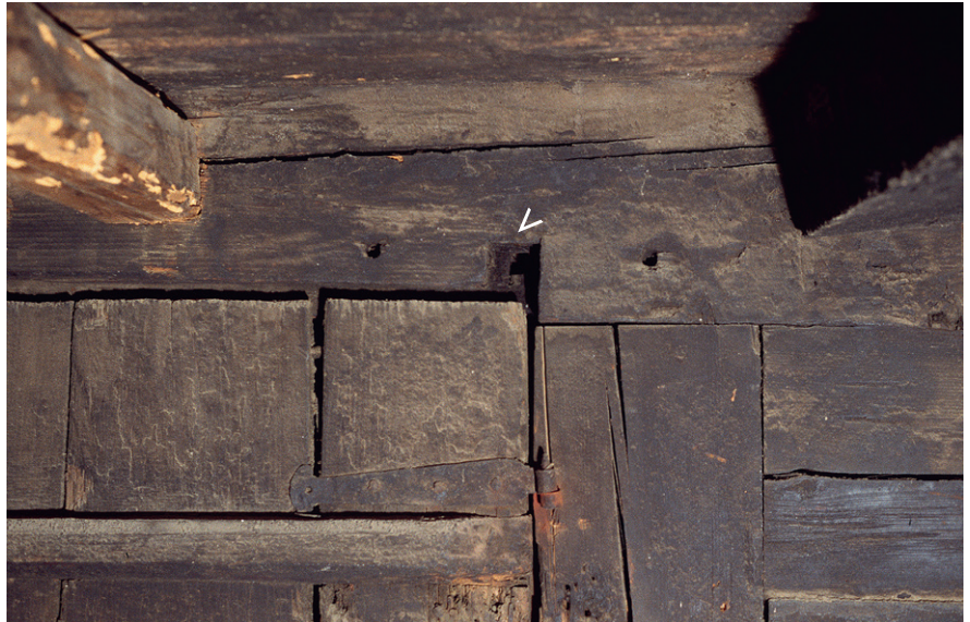
Abb. 45: Einschnitt für einen am Türblatt vorstehenden Drehzapfen im Haus Halthof in Menzingen (Kat. 3), nicht vor 1457d; die Löcher links und rechts des Einschnittes stammen von der Befestigung einer Fixierleiste.
