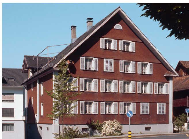
Abb. 242: Das Haus Hauptstrasse 5, aufgenommen vor dem Abbruch 2006; Ansicht von Osten.
