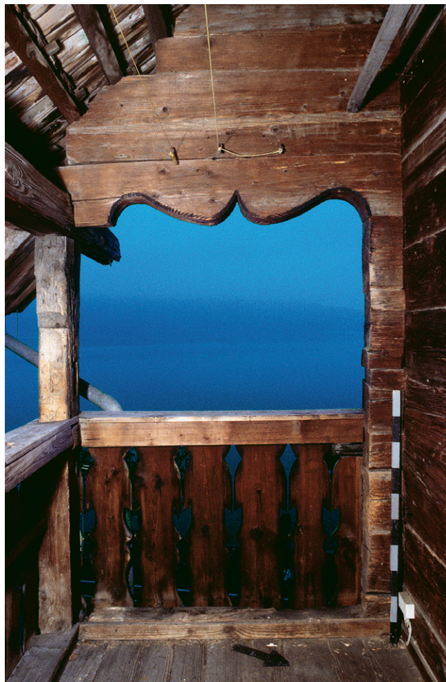
Abb. 66: Mit Kielbogen gestalteter giebelseitiger Abschluss einer Laube beim Haus Zugerstrasse 10 in Walchwil, 1610d (Ereignisnr. Archäologie 1520).
