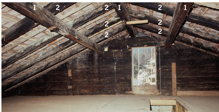
Abb. 57: Dachwerk mit firstparallelen Pfetten (1) und den quer darauf verlegten Rafen (2) im Haus Alosenstrasse 4 in Oberägeri (Kat. 9), 1508d.
