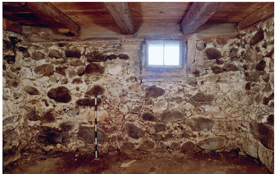
Abb. 191: Der gesamte Grundriss des Sockelgeschosses von Haus Neudorfstrasse 6 in Menzingen wurde von firstparallelen Balken überspannt.
