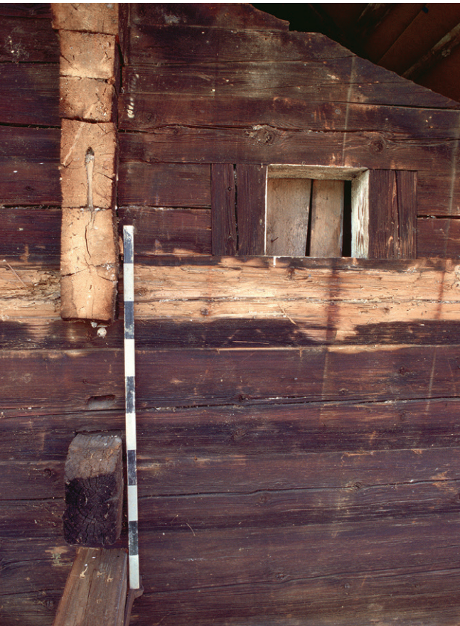
Abb. 123: Der auf die Fassadenflucht abgebeilte Zierfries hebt sich bei Haus Unteräckeri (Kat. 18), 1510d oder kurz danach, als heller Streifen von der dunkel gestrichenen Blockoberfläche ab.
