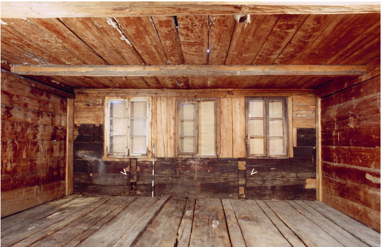
Abb. 175: Anhand von Verkämmungsnegativen war die Grundfläche der bauzeitlichen Firstkammer (3.1) von Haus Halthof in Menzingen zu bestimmen.
