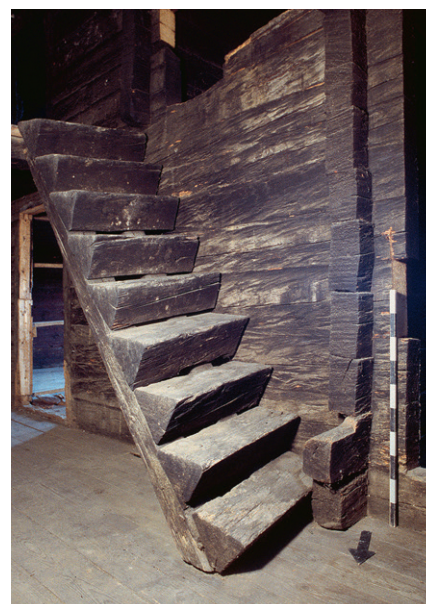
Abb. 103: Die Blockstiege in Haus Lauihof in Walchwil (Kat. 24), 1536d oder kurz danach, befindet sich nicht mehr an ihrer ursprünglichen Lage.
