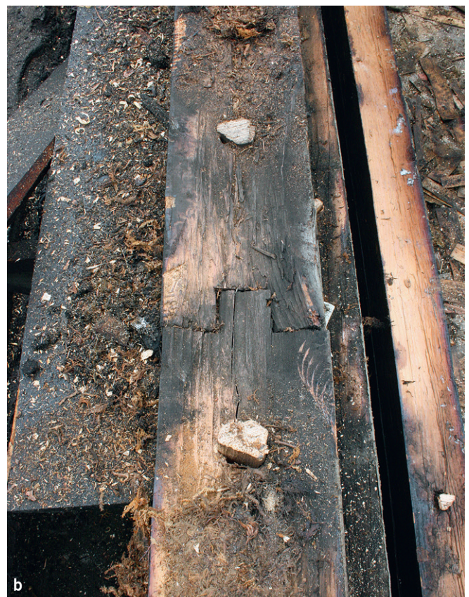
Abb. 22: Mit stehender Nut-Kamm-Verbindung zusammengestückte Balkenlage in einer Firstkammerwand im Haus Grubenstrasse 37 in Oberägeri (Kat. 11), 1518d: a) Wandansicht mit angestückter Balkenlage; b) Aufsicht auf die angestückte Balkenlage nach Abbau der darüberliegenden Wand.
