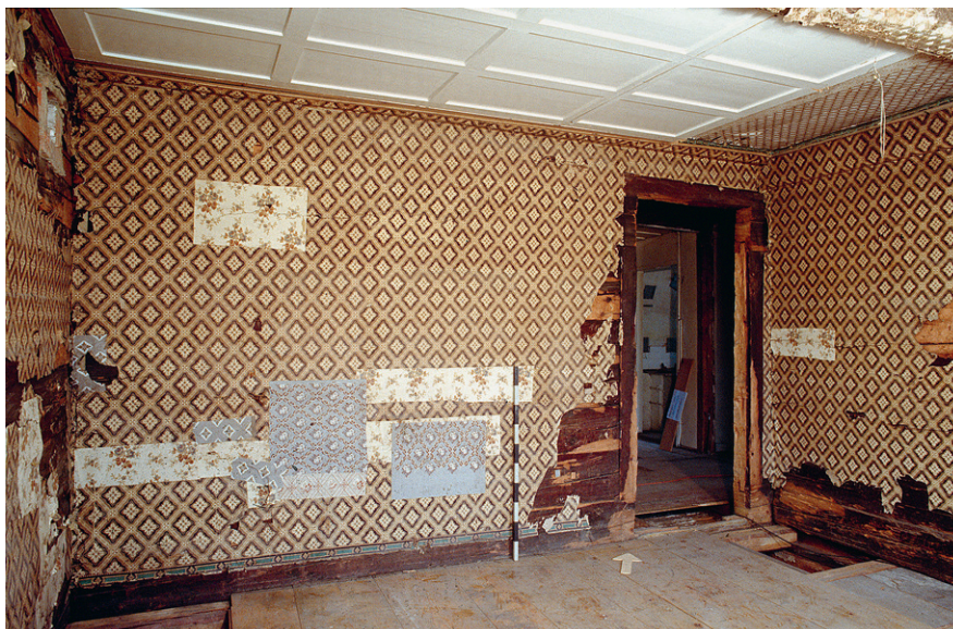
Abb. 197: Die bauzeitliche Türöffnung der Eckkammer (2.3) von Haus Neudorfstrasse 6 in Menzingen war nur 1,47 m hoch und 70 cm breit.
