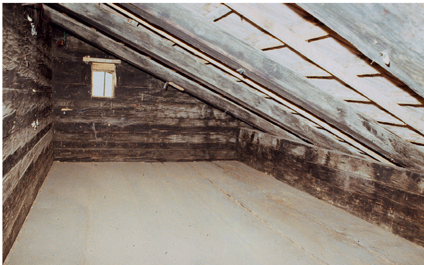
Abb. 65: Blick in einen Schlupf mit Kniestock von Haus Alosenstrasse 4 in Oberägeri (Kat. 9), 1508d.
