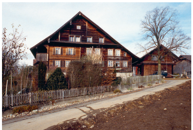
Abb. 281: Das Haus Berchtwil 2, aufgenommen während der Bauunter- suchung 2010; Ansicht von Süden.
