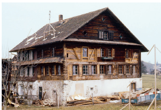
Abb. 200: Das Haus Hinterburgstrasse 44/46, aufgenommen während des Umbaus 1989; Ansicht von Süden.
