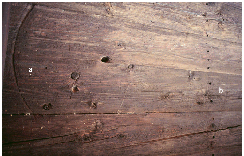
Abb. 108: Fassade im Bereich der ursprünglichen Laube von Haus Artherstrasse 125/127 in Oberwil bei Zug (Kat. 27), 1577d: a) Drehfurchen einer unbekanntes Gerätschaft; b) die Löcher von den einstigen Zapfen eines Zettelrahmens.
