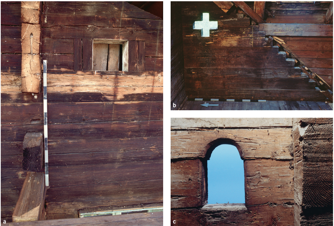
Abb. 36: Heiterlöcher von unterschiedlicher Form: a) Haus Unterblacki in Unterägeri (Kat. 18), 1510d oder kurz danach; b) Haus Artherstrasse 125/127 in Oberwil bei Zug (Kat. 27), 1577d; c) Haus Zugerstrasse 10 in Walchwil, 1665d (Ereignisnr. Archäologie 1520).
