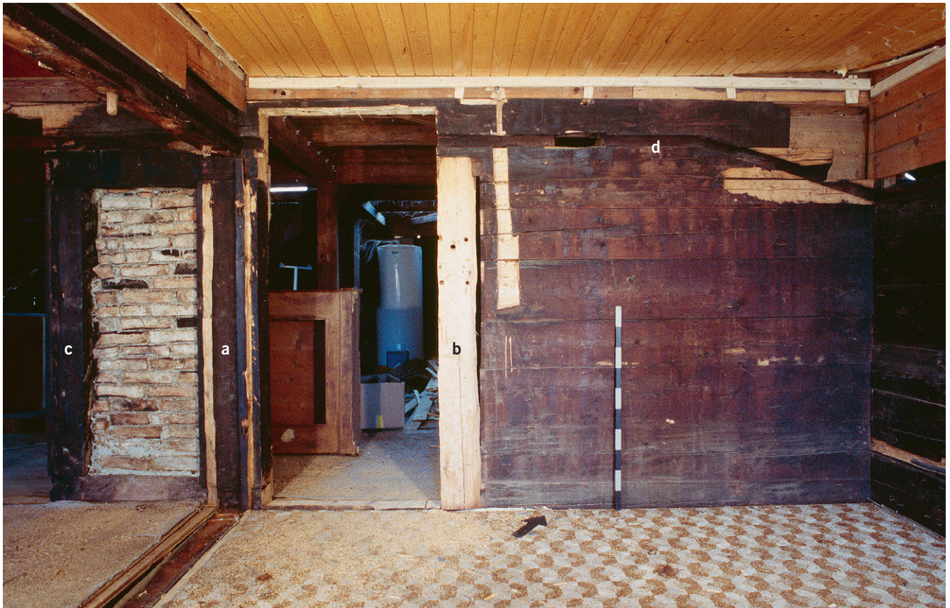
Abb. 218: Querwand im Bereich der Dachkammern (3.1 und 3.2) von Haus Eggstrasse 57 in Oberägeri: a) Doppeltürpfosten; b) Pfosten der Türöffnung zur östlichen Dachkammer (3.1); c) Pfosten der Türöffnung zur westlichen Dachkammer (3.2); d) Nut zur Einbringung der Deckenbohlen in der östlichen Dachkammer (3.1).
