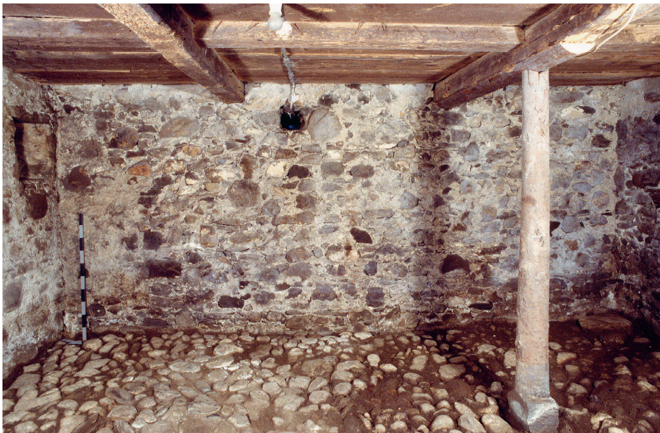
Abb. 271: Die Pflasterung im nördlichen Keller (0.2) von Haus Unterblacki in Unterägeri dürfte aus der Bauzeit stammen.
