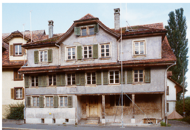
Abb. 323: Das Haus Artherstrasse 128, aufgenommen vor dem Abbruch 2003; Ansicht von Nordosten.
