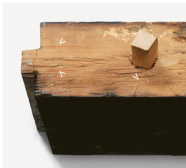
Abb. 13: Die Balken wurden für die weitere Zurichtung mit Röteln- und Risslinien markiert. Wandbalken aus Haus Grubenstrasse 37 in Oberägeri (Kat. 11), 1518d.
