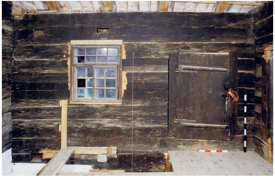
Abb. 224: Bauzeitliche Türöffnung auf die östliche Laube in der Trauffassade von Haus Grubenstrasse 37 in Oberägeri.
