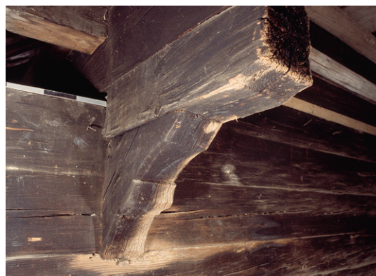
Abb. 58: Winkelholz bei der Mittelpfette an der rückwärtigen Giebfassade von Haus Unterblacki in Unterägeri (Kat. 18), 1510d oder kurz danach.
