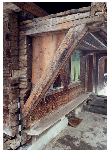
Abb. 68: Bauzeitliche Laubenkonstruktion mit aus dem Wandverband herauswachsendem Trägerbalken und Strebe bei der rückwärtigen Giebelfassade von Haus Chammersbüel in Unterägeri (Kat. 16), 1598d.
