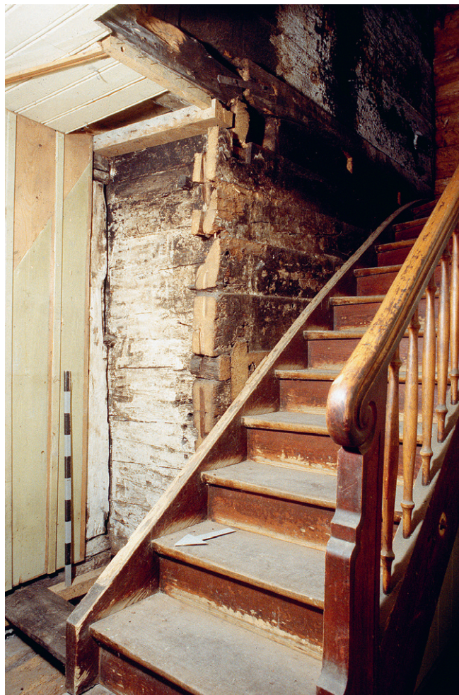
Abb. 328: Ungewöhnliche Eckverkämmung der Binnenwände der Eckkammer (1.3) im ersten Vollgeschoss von Haus Artherstrasse 128 in Oberwil bei Zug. Die nördliche Kammerwand ist in die westliche eingenuet, wobei ein Balken in halber Wandhöhe sowie die beiden untersten Wandbalken die Westwand durchstiessen.
