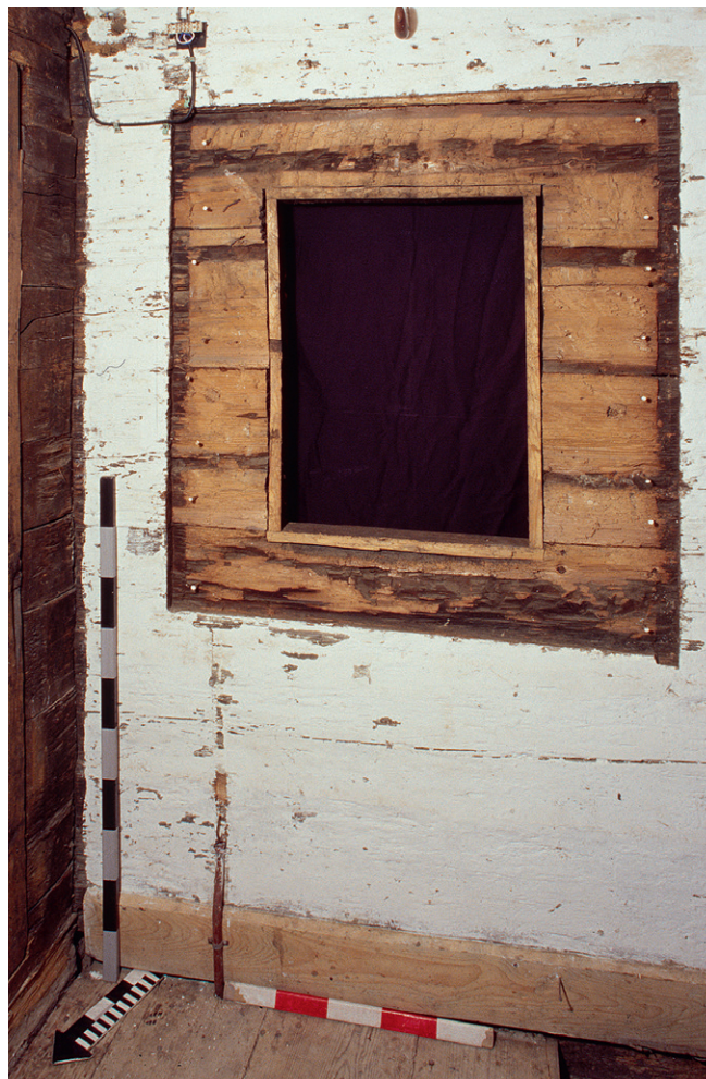
Abb. 39: Bei Haus Grubenstrasse 37 in Oberägeri (Kat. 11), 1518d, zeichnet sich gangseitig das Negativ eines nachträglich hinter der binnenfensterartigen Wandöffnung angebrachten Korpus ab. Aus der Stube waren unmöglich alle Regalbretter darin zu bedienen.
