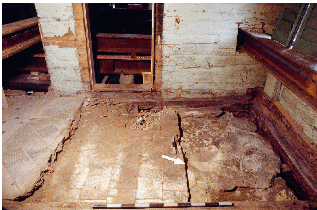
Abb. 289: Im Küchen- und Gangbereich dürften im Gründungsbau von Haus Holzhäuserstrasse 2 in Risch durchgehend flache Steine verlegt gewesen sein. Sichtbar sind jüngere Bodenbeläge und die vermutlich bauzeitliche Steinsetzung. Blick aus der abgebauten Eckkammer (1.3) nach Westen in den Gang (1.4).
