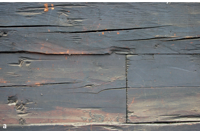
Abb. 22: Mit stehender Nut-Kamm-Verbindung zusammengestückte Balkenlage in einer Firstkammerwand im Haus Grubenstrasse 37 in Oberägeri (Kat. 11), 1518d: a) Wandansicht mit angestückter Balkenlage; b) Aufsicht auf die angestückte Balkenlage nach Abbau der darüberliegenden Wand.
