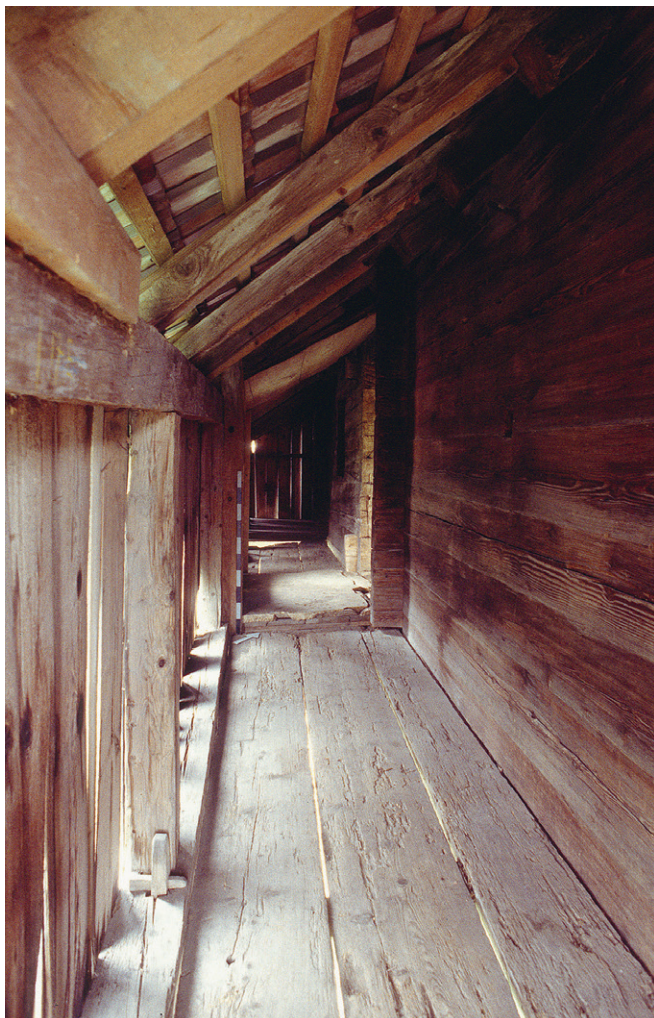
Abb. 272: Bei den Fussbodenbrettern der südlichen Laube von Haus Unterblacki in Unterägeri dürfte es sich um die bauzeitlichen handeln; ursprünglich war die Laube oberhalb einer Brüstung offen.
