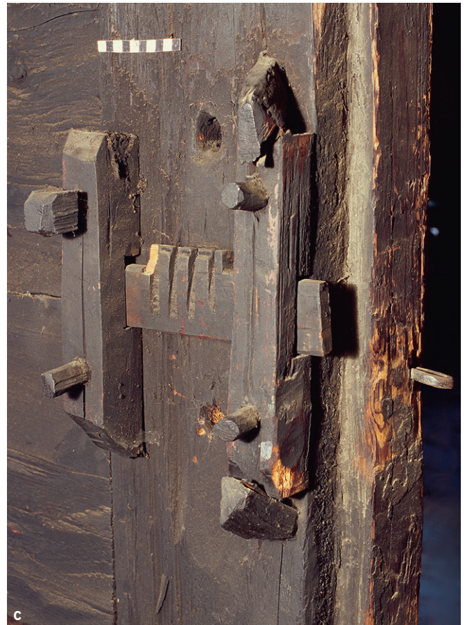
Abb. 46: Verschiedene Verschlussvorrichtungen bei Türöffnungen: a) Drehriegel im Haus Halthof in Menzingen (Kat. 3), nicht vor 1457d; b) Schwenkriegel im Haus Hinterburgstrasse 44/46 in Neuheim (Kat. 8), 1429d; c) Schubriegel im Haus Grubenstrasse 37 in Oberägeri (Kat. 11), 1518d.
