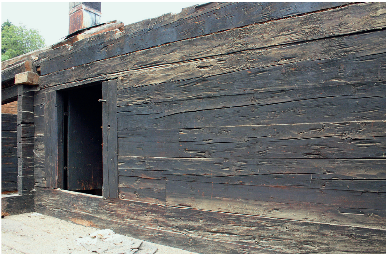
Abb. 12: Spuren der Holzbearbeitung mit dem Beil. Firstkammerwand im Haus Grubenstrasse 37 in Oberägeri (Kat. 11), 1518d.
