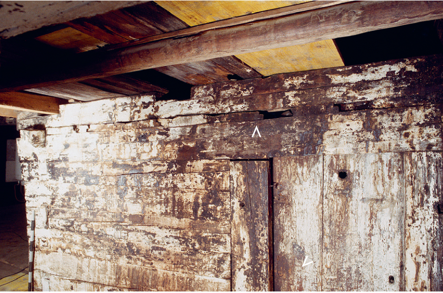
Abb. 173: Gegen das Hausinnere war die Decke der Eckkammer (2.3) von Haus Halthof in Menzingen wandsichtig angelegt.
