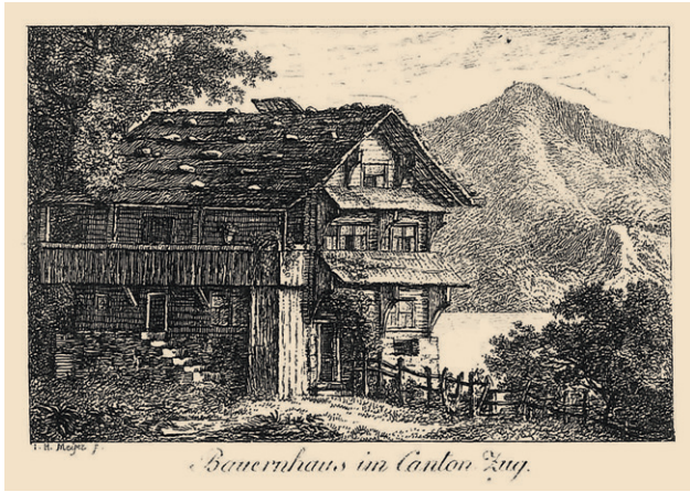
Abb. 62: Mit Legeschindeln gedecktes Hausdach im Kanton Zug. «Bauernhaus im Canton Zug», Zeichner und Radierer Johann Heinrich Meyer, Zürich, 1806.
