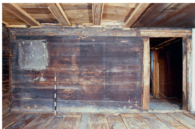
Abb. 259: Die binnenfensterartige Wandöffnung in der Stube (1.1) im Haus Chammersbüel in Unterägeri.
