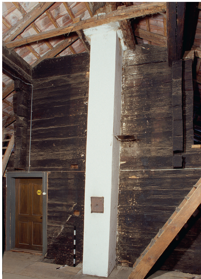
Abb. 61: Die Mittelpfetten liegen bei Haus Grubenstrasse 37 in Oberägeri (Kat. 11), 1518d, auf den Wänden der Firstkammer auf und spannen sich ab dort über den offenen Bereich der Rauchküche im Hinterhaus.
