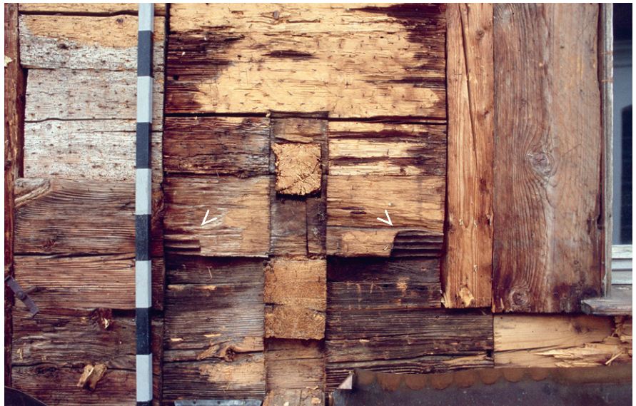
Abb. 302: Zierfries am Brüstungsbalken im ersten Vollgeschoss an der Westfassade von Haus Dorfstrasse 17/19 in Walchwil.
