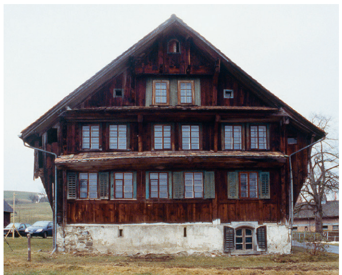
Abb. 267: Das Haus Unterblacki in Unterägeri, aufgenommen vor dem Umbau 2008/09; Ansicht von Osten.
