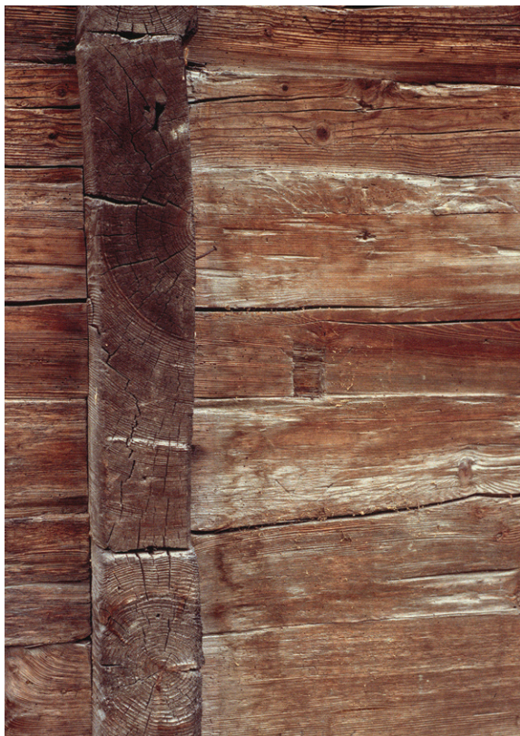
Abb. 14: Die Wandbalken der Blockbauten verfügen über das Herzstück des Stammes oder wenigstens die Hälfte davon. Binnenwandvorstösse beim Haus Vorderbergstrasse 38 in Walchwil, undatiert (Ereignisnr. Archäologie 883).
