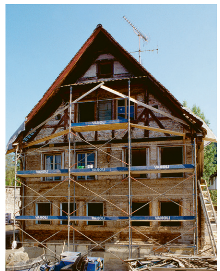
Abb. 316: Das Haus Kirchmattstrasse 10, aufgenommen während des Umbaus 1997; Ansicht von Westen.
