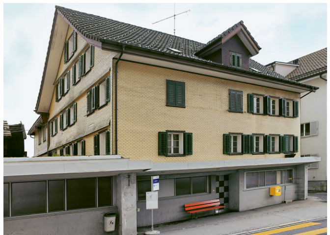
Abb. 183: Das Haus Hauptstrasse 16, aufgenommen vor dem Abbruch 2012; Ansicht von Südwesten.
