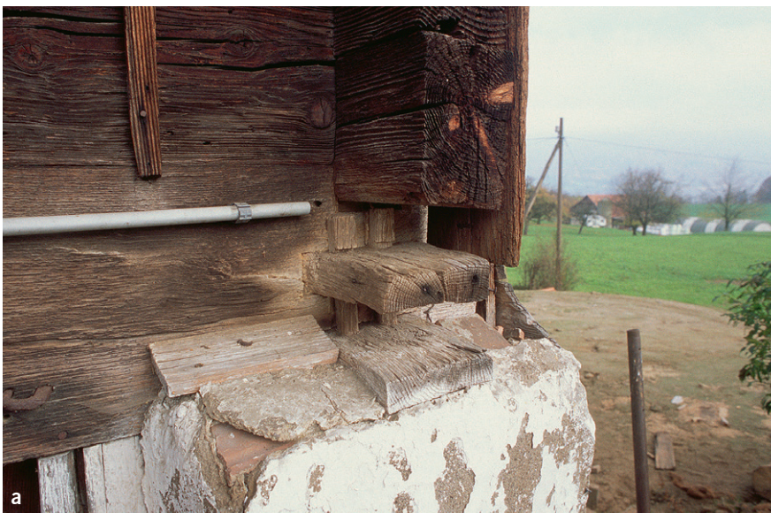
Abb. 19: Schwellenschlösser bei Haus Stockeri 9 in Risch (Kat. 21), 1557d: a) zweizungiges Schwellenschloss bei einer Hausecke; b) einzungiges Schloss bei einer Binnenwand.
