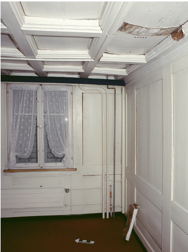
Abb. 52: Die bauzeitliche Bohlen-Balkendecke in der Stube von Haus Hauptstrasse 5 in Oberägeri (Kat. 13), 1547d, wurde zu einer «Kassetendecke» umgestaltet.
