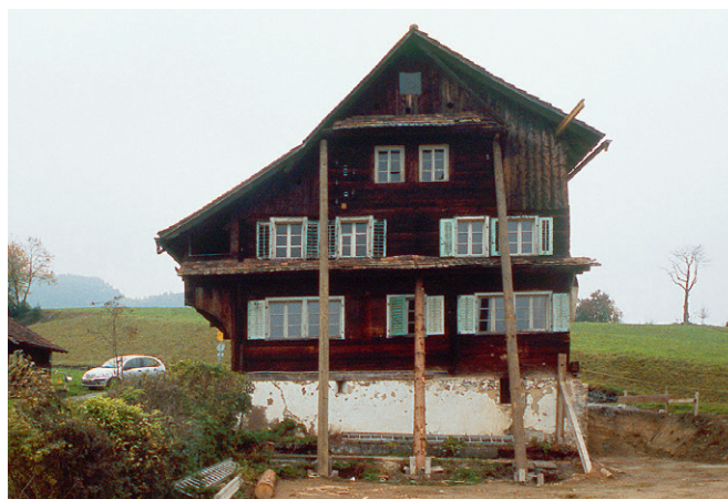
Abb. 292: Das Haus Stockeri 9, aufgenommen während des Umbaus 2011/12; Ansicht von Süden.
