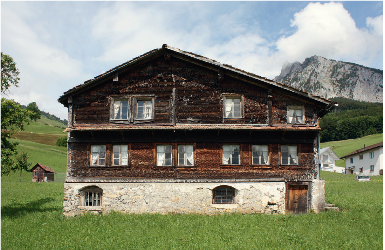
Abb. 154: Haus Büöliti im Ried ob Schwyz SZ wurde 1298d errichtet; aufgenommen während der Untersuchung 2012; Ansicht von Süden.
