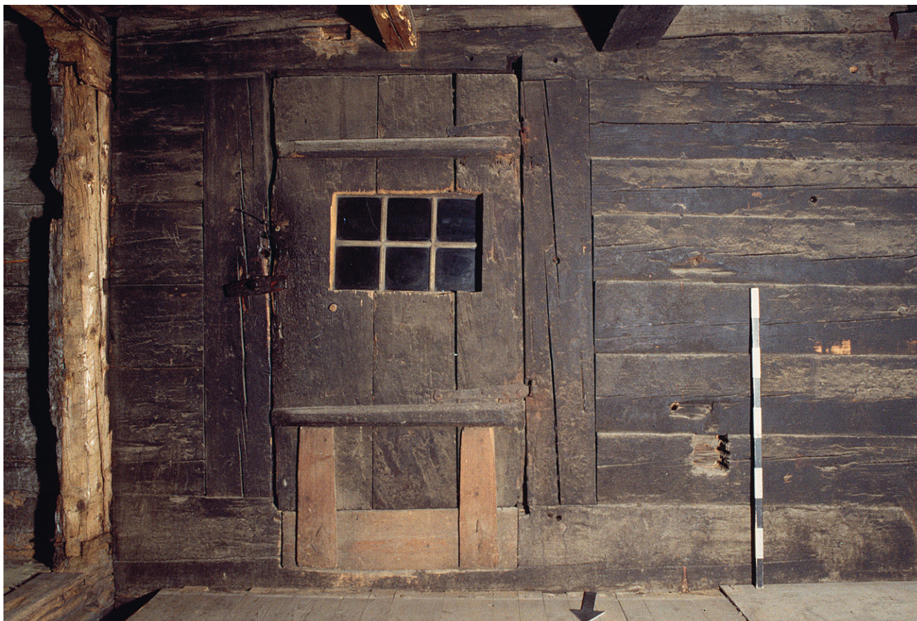
Abb. 44: In der Höhe vergrößerte Türöffnung mit verlängertem und ausgeschnittenem bauzeitlichem Türblatt im Haus Halthof in Menzingen (Kat. 3), nicht vor 1457d.
