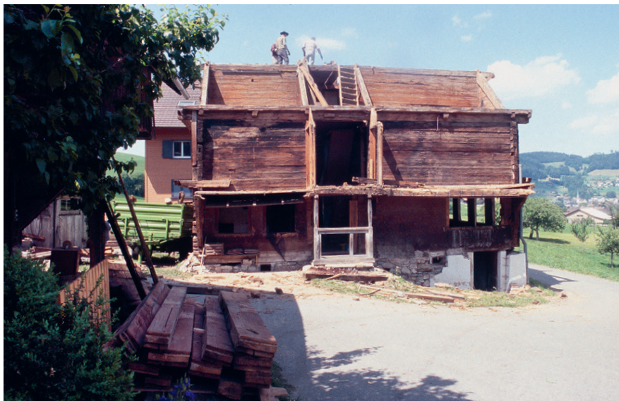
Abb. 257: Die südliche Trauffassade von Haus Chammersbüel in Unterägeri während des Abbruchs 2009.
