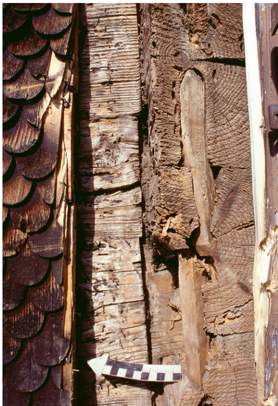
Abb. 27: Dicht versetzte Dübel in einem Eckgewält von Haus Hauptstrasse 5 in Oberägeri (Kat. 13), 1547d; die Dübel wurden erst durch die spätere Kürzung der Vorstösse freigelegt.
