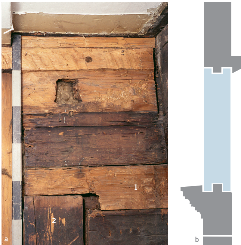
Abb. 34: Über einer Fensteröffnung im Haus Kirchmattstrasse 10 in Zug (Kat. 26), 1459d oder kurz danach, bestand ein konsolenartiges Gesims: a) 1: Auf die Wandflucht abgearbeitetes Gesims am Fenstersturzbalken, 2: Fensterposten mit farblichem Negativ des abgearbeiteten Gesimses; b) Querschnitt durch den Fensterposten, den Fenstersturzbalken und den Fensterbrüstungsbalken (Rekonstruktion).
