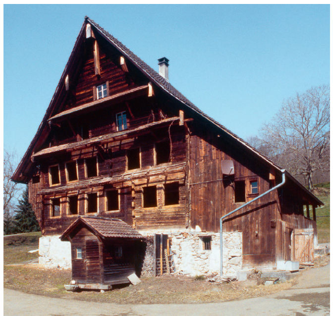
Abb. 309: Das Haus Lauihof, aufgenommen während des Abbruchs 2005; Ansicht von Südwesten.
