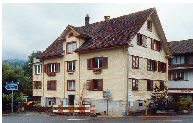
Abb. 231: Das Haus Hauptstrasse 1, aufgenommen vor dem Abbruch 1996; Ansicht von Nordosten.
