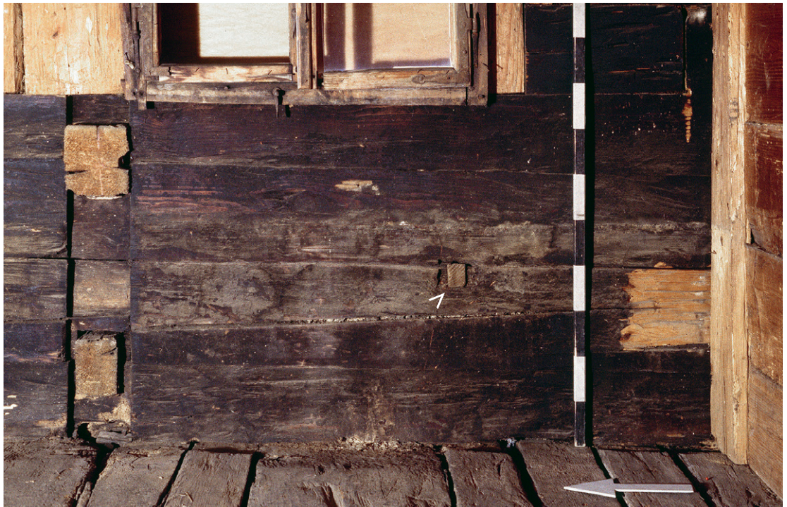
Abb. 167: Negativ einer Verankerung für ein Schutzdach in einer Kammer im Haus Halthof in Menzingen.
