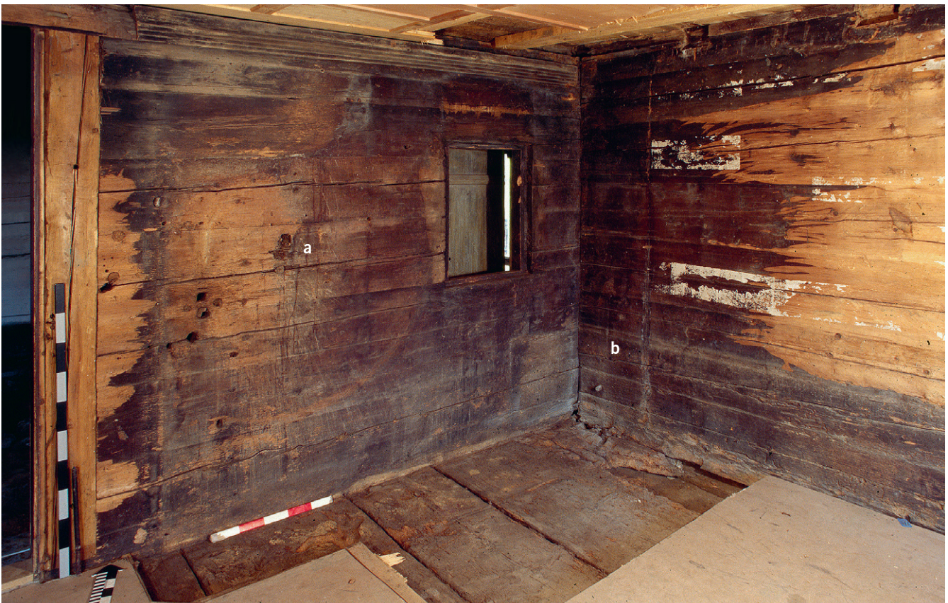
Abb. 226: Gründungszeitlich waren die Stubenwände von Haus Grubenstrasse 37 in Oberägeri nicht verkleidet; sie weisen zahlreiche Spuren der Nutzung auf: a) Drehspuren einer unbekanntenen Gerätschaft; b) Schmutznegativ einer Sitzbank.
