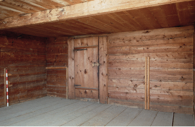
Abb. 125: Die Kammerwände in Haus Gutsch in Zug, 1536 (Ereignisnr. Archäologie 302), waren vermutlich mit einem transparenten Anstrich versehen worden.
