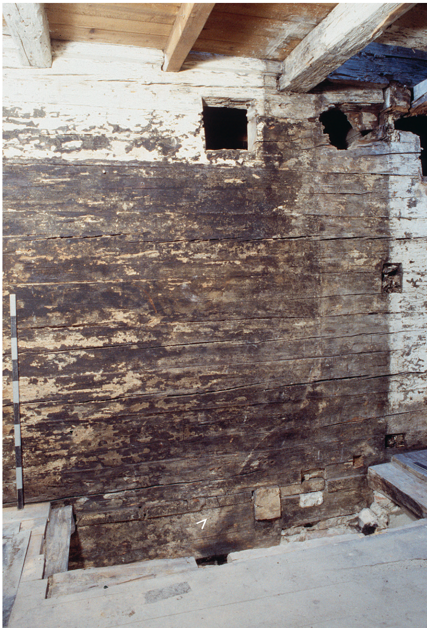
Abb. 47: Wandsichtige Fussbodenbohlen an der Querwand im ersten Vollgeschoss beim Haus Hauptstrasse 6 in Menzingen (Kat. 4), 1423d.
