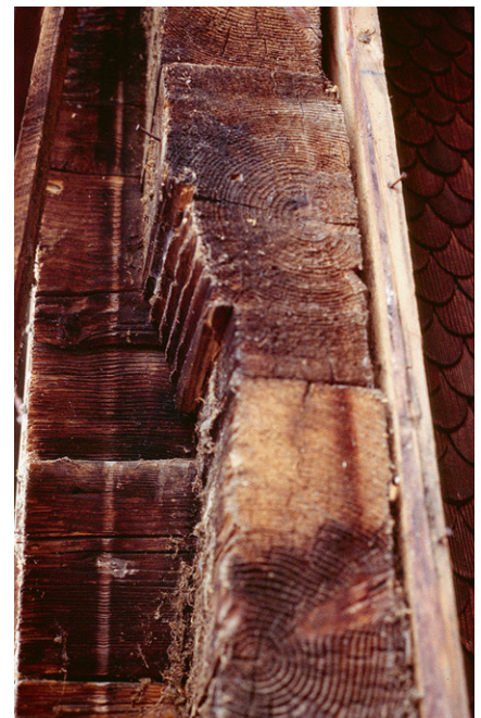
Abb. 211: Mit gekehltm Fries verzierter vor-springender Brüstungsbalken in der giebelständigen Hauptfassade von Haus Eggstrasse 57 in Oberägeri.
