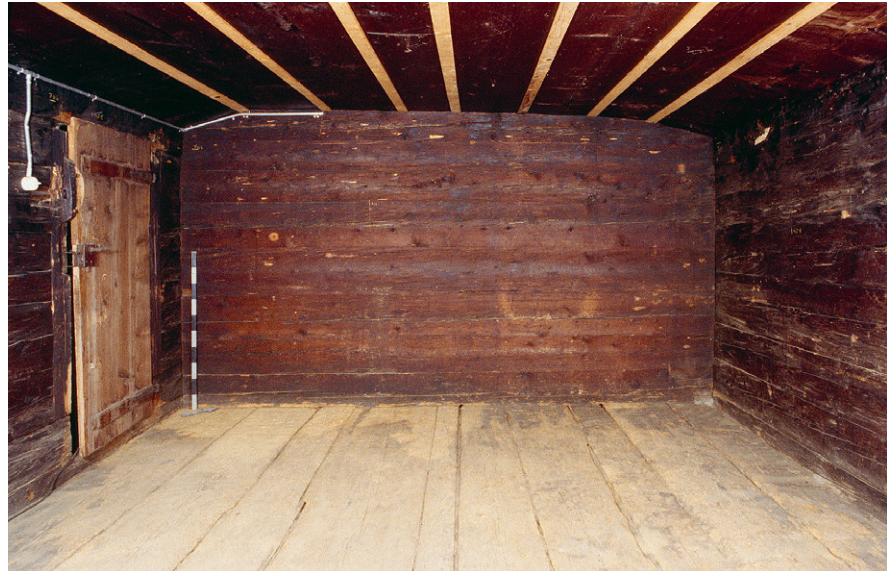
Abb. 278: Die Firstkammer (3.1) von Haus Unterblacki in Unterägeri mit abgeschrägter Decke. Blick nach Westen. Die Leisten über den Fugen zwischen den Bohlen wurden erst in jüngster Zeit aufgenagelt.
