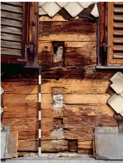
Abb. 190: Die firstparallele Trennwand zwischen Stube (1.1) und Nebenstube (1.2) durchstieß bei Haus Neudorfstrasse 6 in Menzingen die Fassade als Kombination von Einzelvorstössen und Vorstossreihe.
