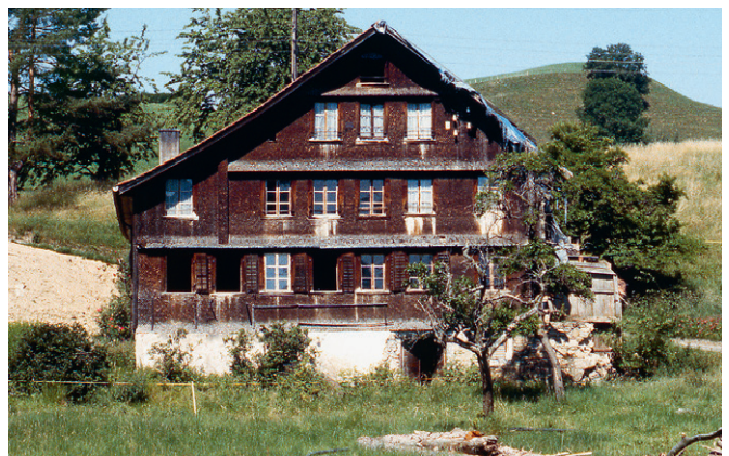
Abb. 164: Das Haus Halthof vor dem Abbruch 2000; Ansicht von Osten.
