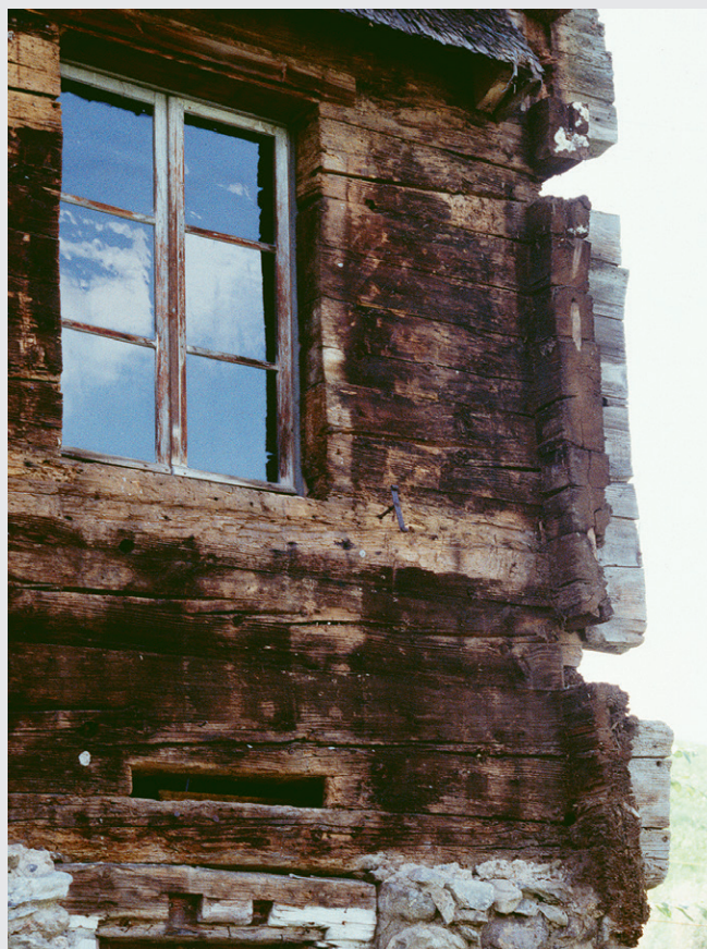
Abb. 54: Treibladenöffnung in der Fassade von Haus Halthof in Menzingen (Kat. 3), nicht vor 1457d, für den Fussboden der Stube.
