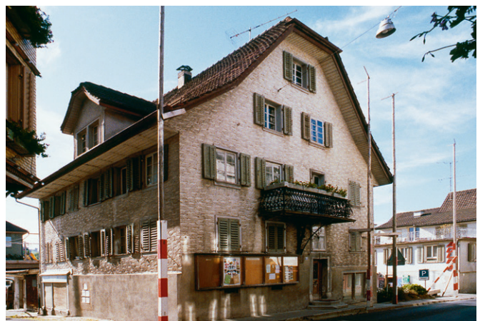
Abb. 180: Das Haus Hauptstrasse 7, aufgenommen vor dem Abbruch 1988; Ansicht von Nordosten.
