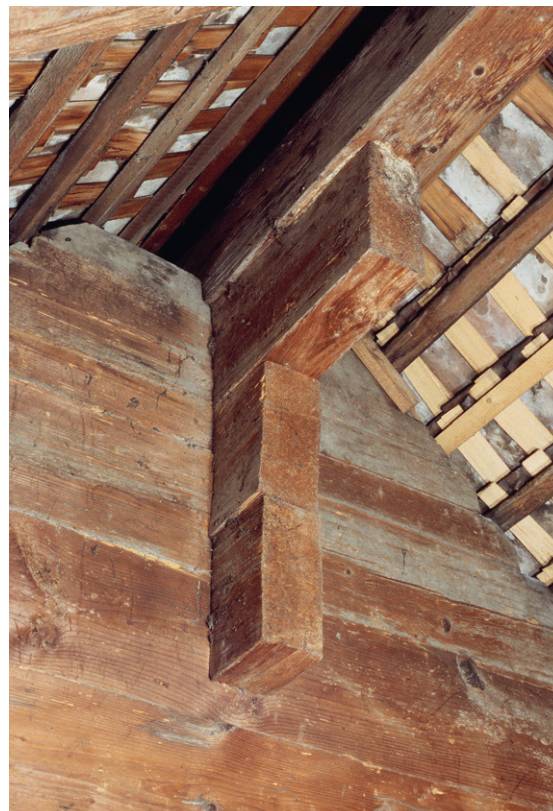
Abb. 30: Querverkämmtes Blockwandstück im Giebfeld von Haus Zugerstrasse 10 in Walchwil, 1665d (Ereignisnr. Archäologie 1520).
