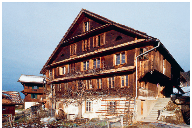
Abb. 207: Das Haus Eggstrasse 57, aufgenommen vor dem Abbruch 2007; Ansicht von Südosten.
