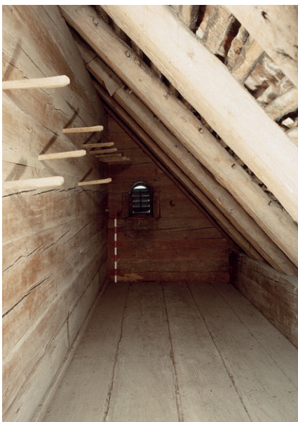
Abb. 106: Holznägel als Aufhängevorrichtungen in einem Schlupf des ersten Dachgeschosses von Haus Gutsch, Zug, 1636 (Ereignisnr. Archäologie 302).
