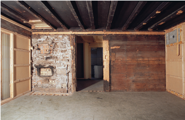
Abb. 51: Bohlen-Balkendecke in der Stube von Haus Hauptstrasse 16 in Menzingen (Kat. 6), 1687d.
