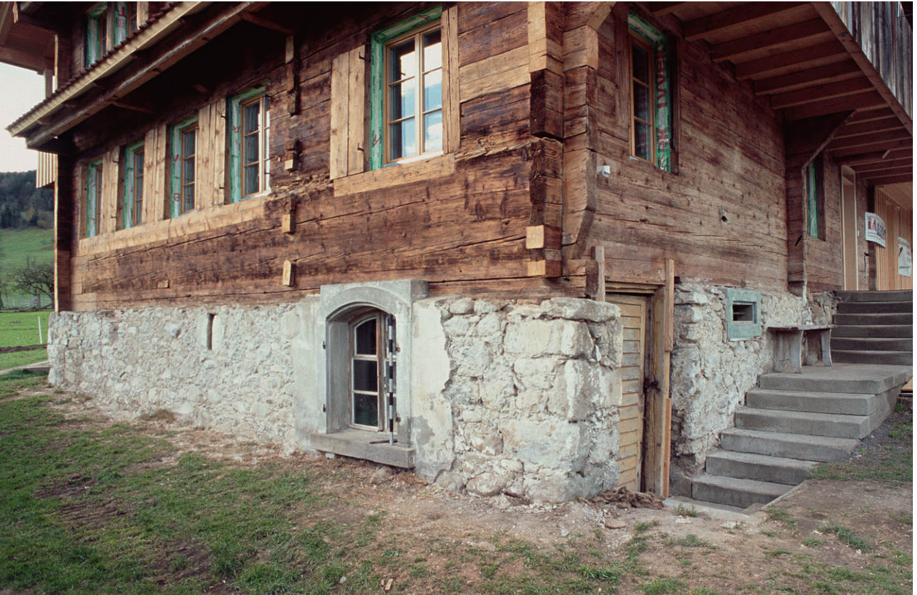
Abb. 21: Eckgewält an der Hausecke, Kombination von Einzelvorstössen und durchgehender Vorstossreihe an der Hauptfassade (Trennwand Stube/ Nebenstube) und durchgehende Vorstossreihe an der Trauffassade (Querwand) bei Haus Unterblacki in Unterägeri (Kat. 18), 1510d oder kurz danach.
