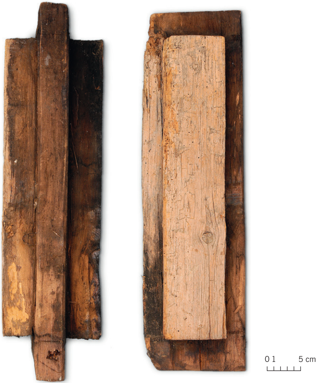
Abb. 32: Fensterpfosten mit umlaufendem Kamm aus Haus Grubenstrasse 37 in Oberägeri (Kat. 11), 1518d.
