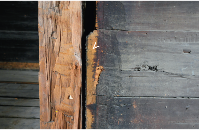
Abb. 121: Der dunkle Anstrich der Stubenwand von Haus Dorfstrasse 17/19 in Walchwil (Kat. 23), 1580d, war hinter den Mantelständer (abgebeilt) gelaufen.
