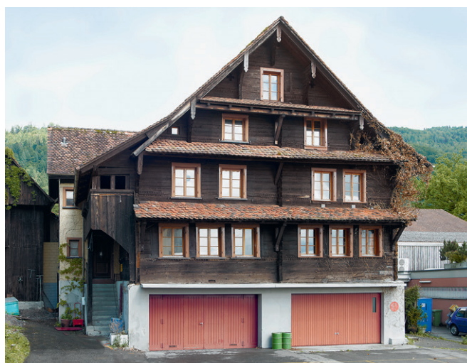
Abb. 320: Das Haus Artherstrasse 125/127, aufgenommen vor dem Abbruch 2003; Ansicht von Nordwesten.
