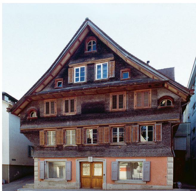
Abb. 177: Das Haus Hauptstrasse 6, aufgenommen vor dem Umbau 2006; Ansicht von Süden.
