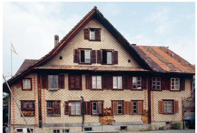
Abb. 186: Haus Neudorfstrasse 6, aufgenommen vor dem Abbruch 1993; Ansicht von Südosten.
