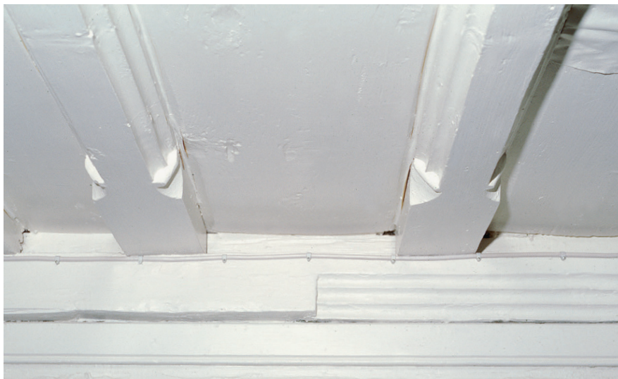
Abb. 237: Die dreifache Kehlung des Konsolgesimses an der Westwand der Eckkammer (1.3) im Haus Hauptstrasse 1 in Oberägeri setzt im Bereich der bauzeitlichen Türöffnung aus.
