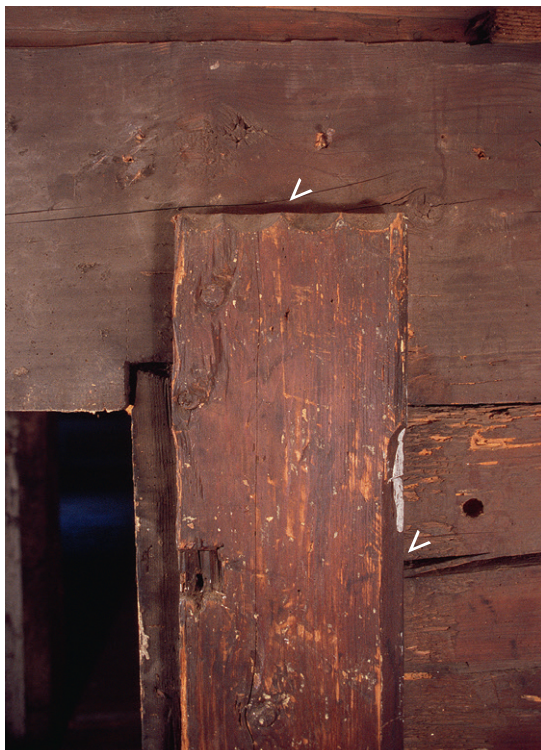
Abb. 109: Mantelständer im Haus Dorfstrasse 17/19 in Walchwil (Kat. 23), 1580d, mit seitlicher Fasse und Schmiege und eingekerbtem Eierfasenmotiv am oberen Abschluss.
