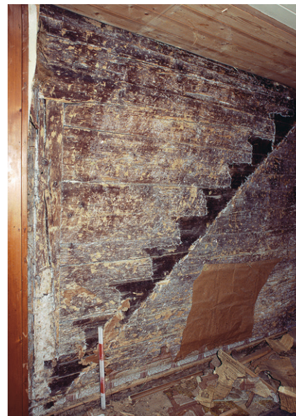
Abb. 102: Negativ einer möglicherweise bauzeitlichen Treppe an der Querwand von Haus Hauptstrasse 5 in Oberägeri (Kat. 13), 1547d.
