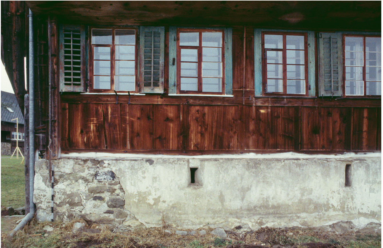
Abb. 3: Die Blockgefüge sind durch gemauerte Sockel vom Boden abgehoben. Haus Unterblacki in Unterägeri (Kat. 18), errichtet 1510d oder kurz danach; Ansicht von Südwesten.
