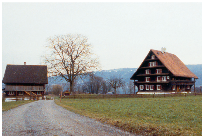
Abb. 295: Das Haus Zweieren 6, aufgenommen während der Bau- untersuchung 2003; Ansicht von Südosten.
