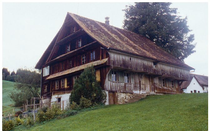
Abb. 264: Das Haus Oberzittenbuch, aufgenommen vor dem Abbruch 2006; Ansicht von Südosten.
