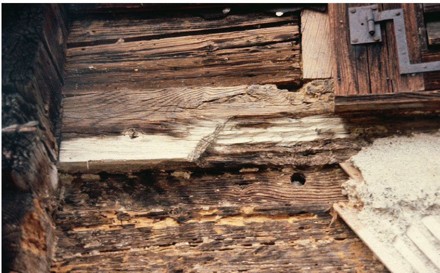
Abb. 111: Gekehlter Zierfries an der Hauptfassade von Haus Unterschwarzenbach in Baar, Allenwinden (Kat. 1), 1595d.
