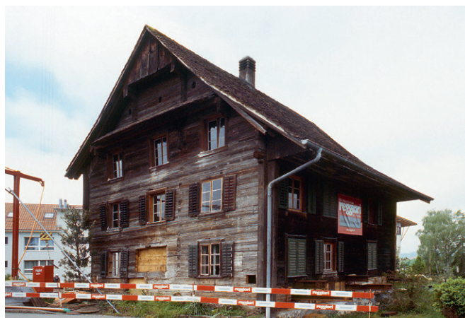
Abb. 284: Das Haus Holzhäusernstrasse 2, aufgenommen vor seiner Verschiebung 2006; Ansicht von Nordosten.
