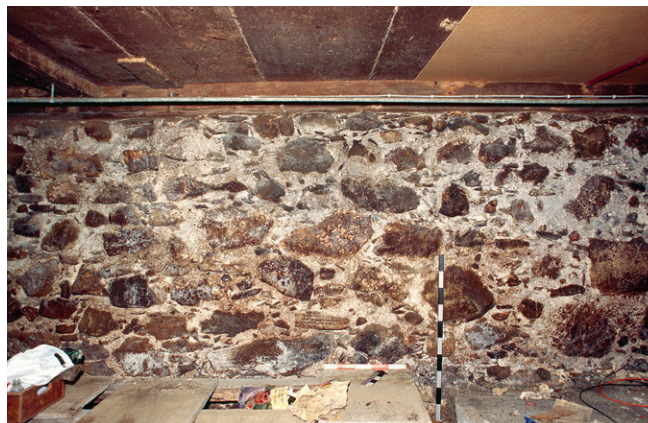
Abb. 223: Ansicht an die Nordmauer des Kellers (0.1) von Haus Grubenstrasse 37 in Oberägeri. Das Mauerwerk ist mehr oder weniger lagig aufgeführt.
