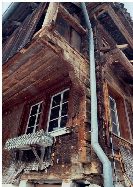
Abb. 67: Bauzeitliche Laubenkonstruktion mit aus dem Wandverband herauswachsendem Trägerbalken und Blockkonsole bei der Hauptfassade von Haus Chammersbüel in Unterägeri (Kat. 16), 1598d.
