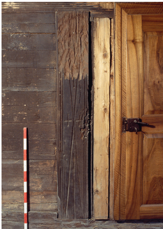
Abb. 110: Mantelständer mit seltener Rillenverzierung im Haus Gutsch in Zug, 1636 (ADA Zug, Ereignisnr. Archäologie 302).
