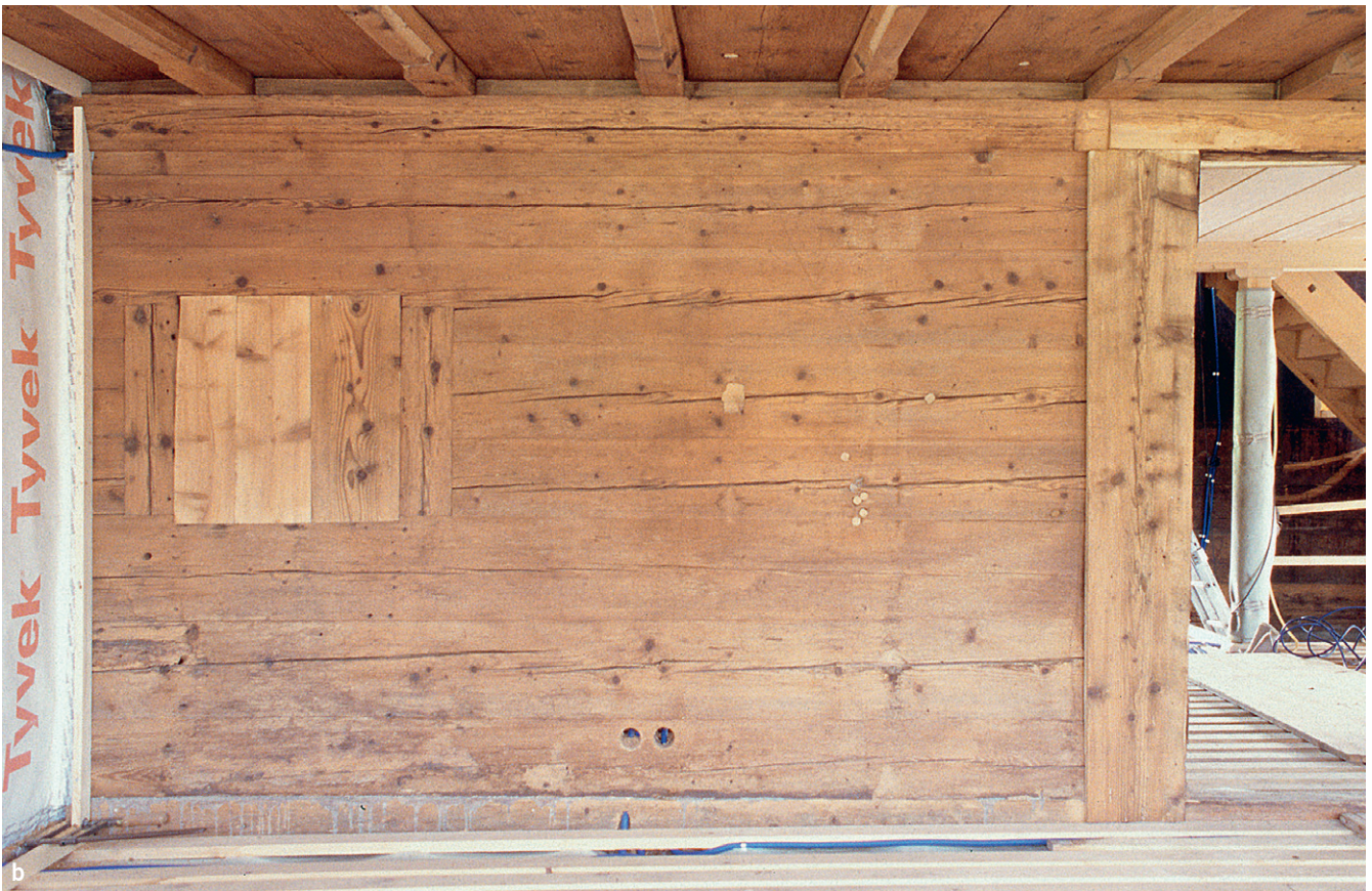
Abb. 124: Die Stube von Haus Unterblacki in Unterägeri (Kat. 18), 1510d oder kurz danach: a) Zustand nach der Freilegung; b) Zustand nach der «Reinigung» der Decke und der Wände.
