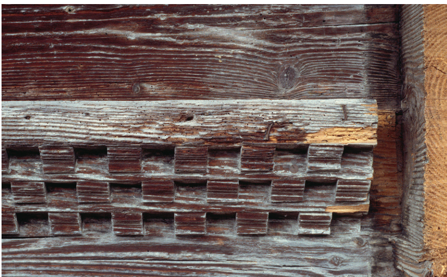
Abb. 113: Würfelries an der Hauptfassade von Haus Zugerstrasse 10, Walchwil, 1665d (Ereignisnr. Archäologie 1520).
