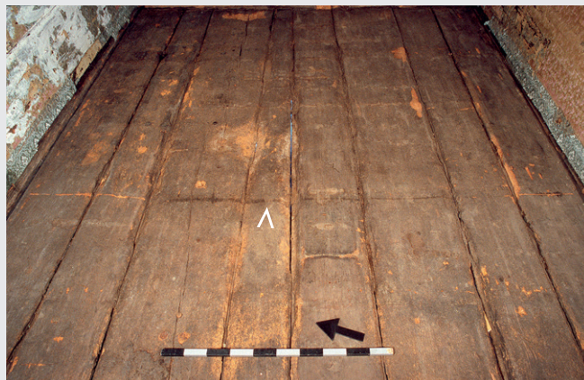
Abb. 53: Aufsicht auf einen Fussboden mit mittig eingebrachtem, keilförmigem Treibladen im Haus Dorfstrasse 17/19 in Walchwil (Kat. 23), 1580d.
