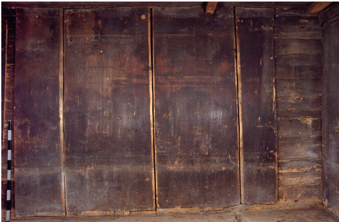
Abb. 135: Das Brettertäfer in der Stube von Haus Unterblacki in Unterägeri (Kat. 18), 1510d, wurde kurz nach 1605d eingebracht.
