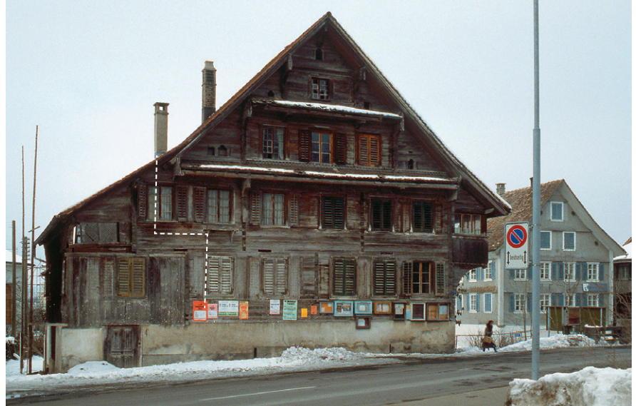
Abb. 71: Traufseitiger Überstand des zweiten Vollgeschosses beim Haus Hauptstrasse 7 in Oberägeri (Kat. 14), 1610d oder kurz danach.
