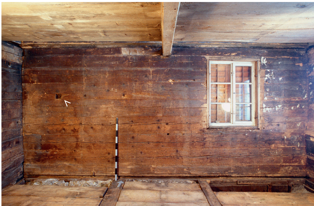
Abb. 260: Ansicht an die Traufwand in der Nebenstube (1.2) im Haus Chammersbüel in Unterägeri. Eine unbekannte Gerätschaft drehte um den rechteckigen Einschnitt.
