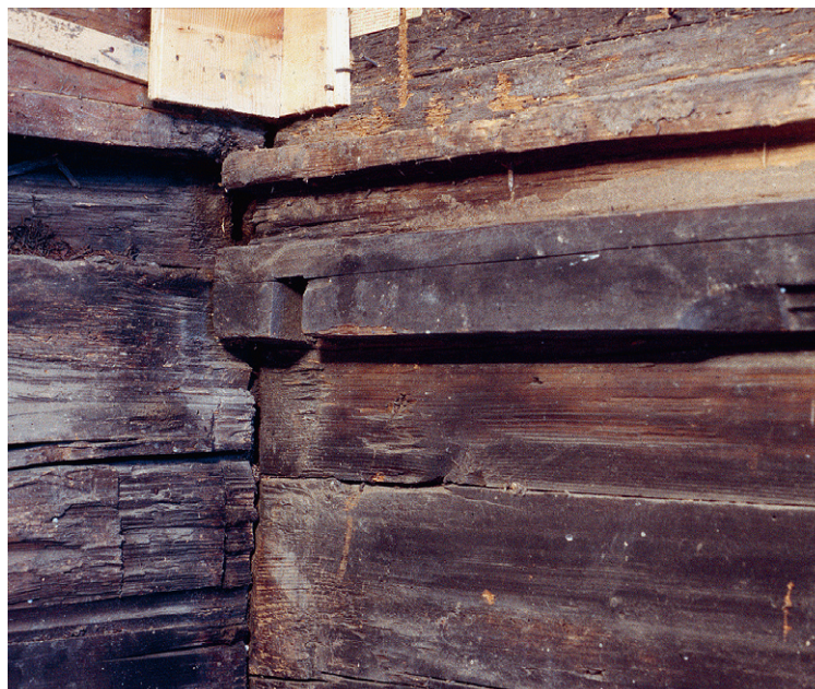
Abb. 214: An den firstparallelen Stubenwänden von Haus Eggstrasse 57 in Oberägeri bestanden Gesimse in der Gestalt von halben Deckenbalken.
