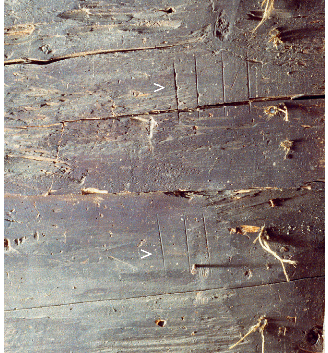
Abb. 330: Eingeritzte Nummerierungszeichen an der Westwand der Kammer (2.2) im zweiten Vollgeschoss von Haus Artherstrasse 128 in Oberwil bei Zug.
