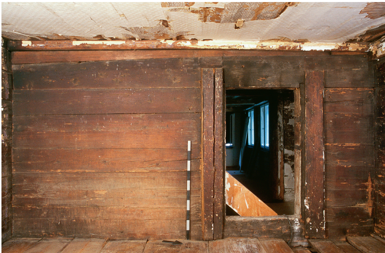
Abb. 307: Ansicht an die Westwand der Eckkammer (2.4) im zweiten Vollgeschoss von Haus Dorfstrasse 17/19 in Walchwil. Die Türöffnung wird von Mantelständern flankiert.
