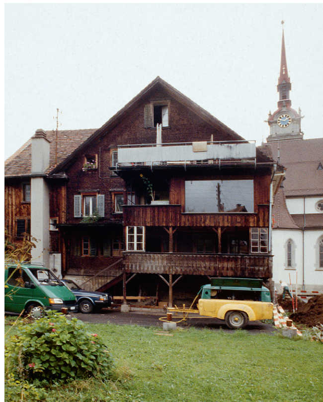
Abb. 235: Die Südfassade von Haus Hauptstrasse 1 in Oberägeri während der Bauuntersuchung.
