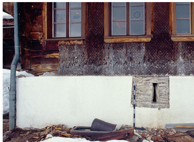
Abb. 256: Schmale Öffnung zum Luft- und Lichteinlass im Sockelmauerwerk von Haus Chammersbüel in Unterägeri.
