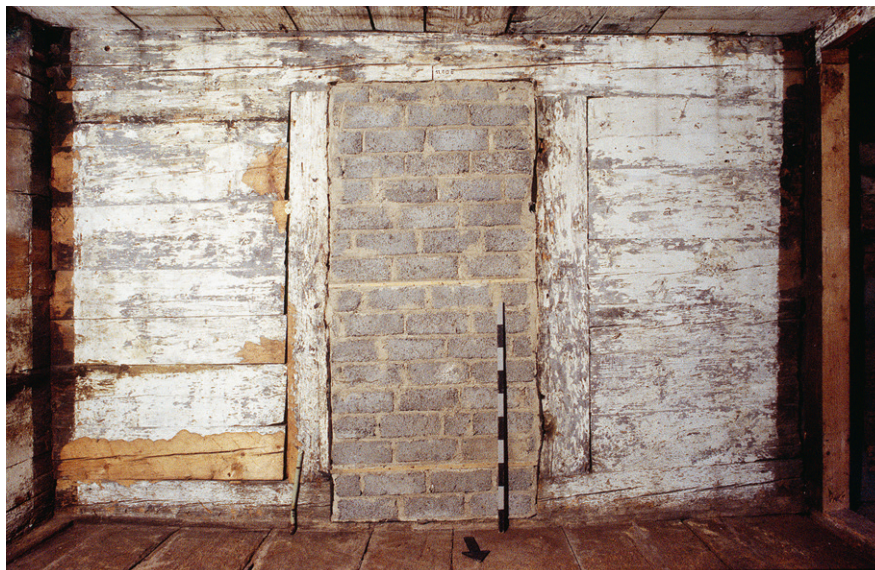
Abb. 327: Originale Türöffnung mit wandbündigen Türpfosten in der Südwand der Nebestube (1.2) im Haus Artherstrasse 128 in Oberwil bei Zug.
