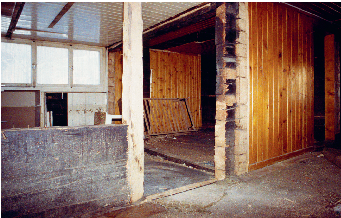
Abb. 216: Zwischen den Eckkammern (2.4) und (2.5) im zweiten Vollgeschoss von Haus Eggstrasse 57 in Oberägeri bestand gegen den offenen Küchenbereich eine Brüstung; wo sekundär die Brüstungsbalken ausgesägt wurden, zeigen die Balkenstirnen keine Verrussung.
