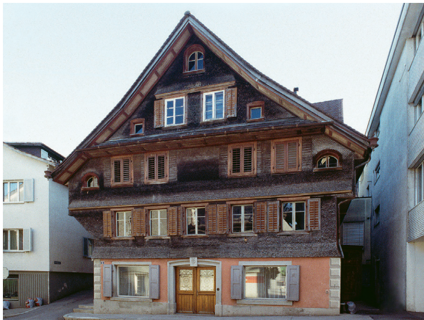
Abb. 138: Der Holzaufbau von Haus Hauptstrasse 6 in Menzingen (Kat. 7), 1423d, präsentierte sich 2006 mit einem Schindelschirm verkleidet.
