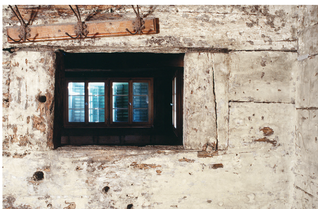
Abb. 40: Binnenfensteröffnung im Haus Stockeri 9 in Risch (Kat. 21), 1557d, ohne offensichtliche Vorrichtung zur Anbringung eines gangseitigen Korpus.
