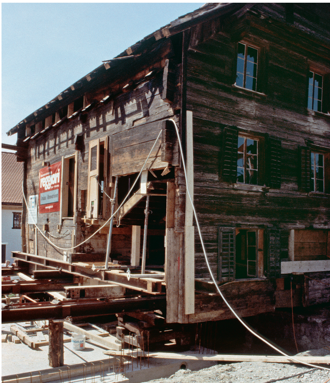
Abb. 4: Der Holzaufbau von Haus Holzhäuserstrasse 2 in Risch (Kat. 20), nicht vor 1462d, wurde 2005 auf ein neu erstelltes Sockelgeschoss verschoben.
