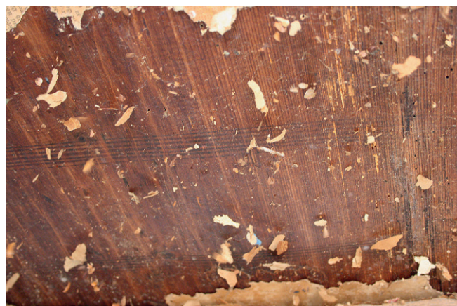
Abb. 120: Eingedrücktes Streifendekor an den Deckenbohlen in einer Kammer im Vorderhaus des zweiten Vollgeschosses im Haus Grubenstrasse 37 in Oberägeri (Kat. 11), 1518d.
