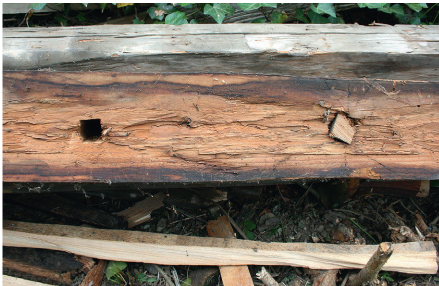
Abb. 11: Die rund ins Nadelholz gebohrten Löcher passen sich beim Schwindvorgang dem Querschnitt der darin steckenden Dübel aus Hartholz an. Balken aus dem Blockgefüge von Haus Grubenstrasse 37 in Oberägeri (Kat. 11), 1518d. Links: leeres Dübelloch, rechts: steckender, gekappter Dübel.
