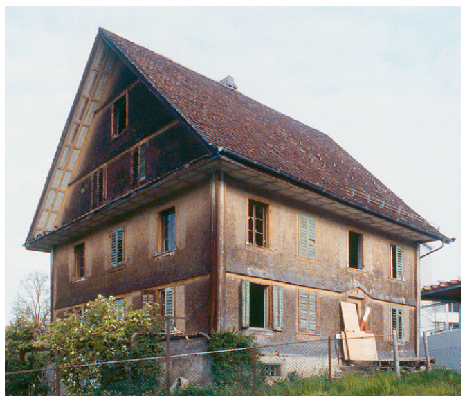
Abb. 248: Das Haus Schulweg 3, aufgenommen vor dem Abbruch 2004; Ansicht von Südosten.
