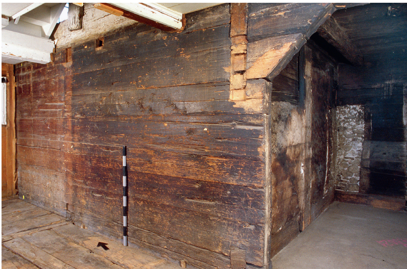
Abb. 305: Ansicht an die Binnenwände der Eckkammer (1.3) im ersten Vollgeschoss von Haus Dorfstrasse 17/19 in Walchwil aus dem Gang (1.1). Die Eckverkämmung ist wegen der bauzeitlichen Öffnung für den Ofen in der Eckkammer (1.3) nicht durchgehend.
