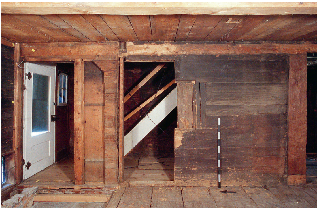
Abb. 304: Ansicht an die Querwand von Haus Dorfstrasse 17/19 in Walchwil in der Stube (1.1). Das Konsolgesims am obersten Wandbalken ist nur noch als Negativstreifen zu erkennen.
