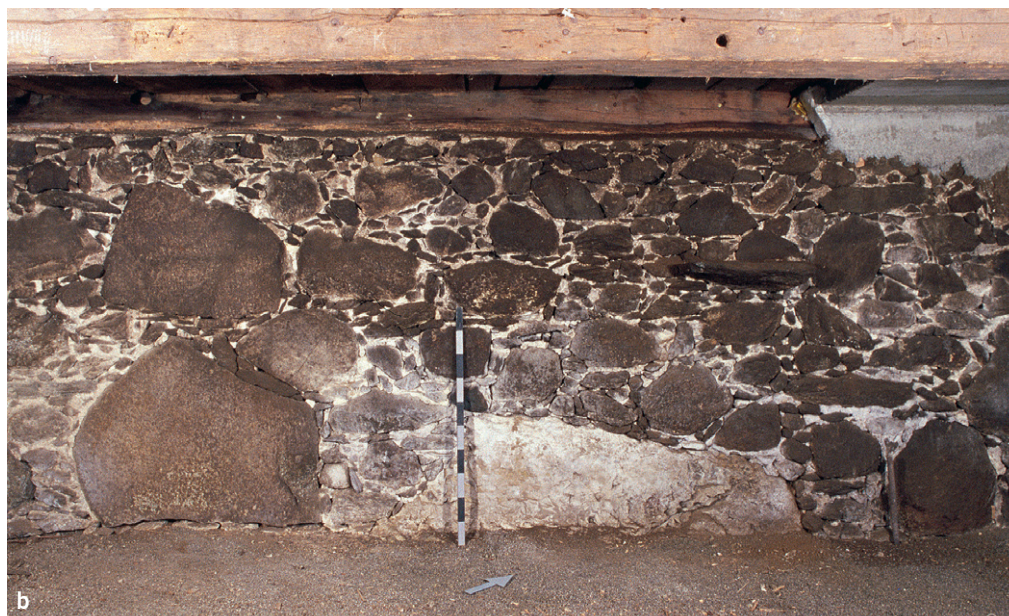
Abb. 5: Sockelmauerwerke von unterschiedlichem Charakter: a) Haus Hauptstrasse 1 in Oberägeri (Kat. 12), 1492d oder kurz danach; typisches Mauerwerk mit mehr oder weniger regelmässigen Steinlagen von unterschiedlicher Höhe; b) Haus Stockeri 9 in Risch (Kat. 21), 1557d; ungewöhnliches Sockelmauerwerk mit gespaltene Gneis- und Granitblöcken.
