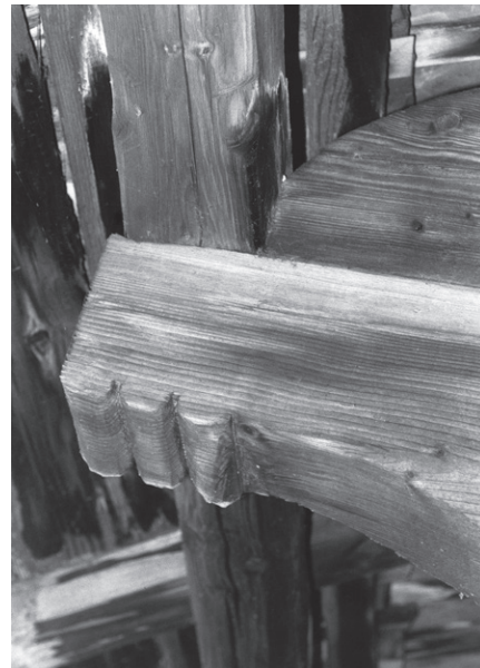
Abb. 118: Wulst-Verzierung am Träger eines Schutzdaches von Hauptstrasse 7 in Oberägeri (Kat. 14), 1610d oder kurz danach.
