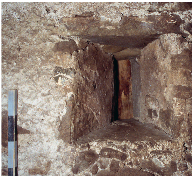
Abb. 6: Fensteröffnung im gemauerten Sockel von Haus Unterblacki in Unterägeri (Kat. 18), 1510d oder kurz danach.
