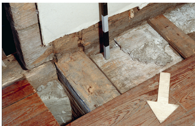
Abb. 195: Über der Balken-Bretterkonstruktion im Gangbereich von Haus Neudorfstrasse 6 in Menzingen hatten sich Reste eines Mörtelbetts mit Abdrücken von Tonplatten erhalten.
