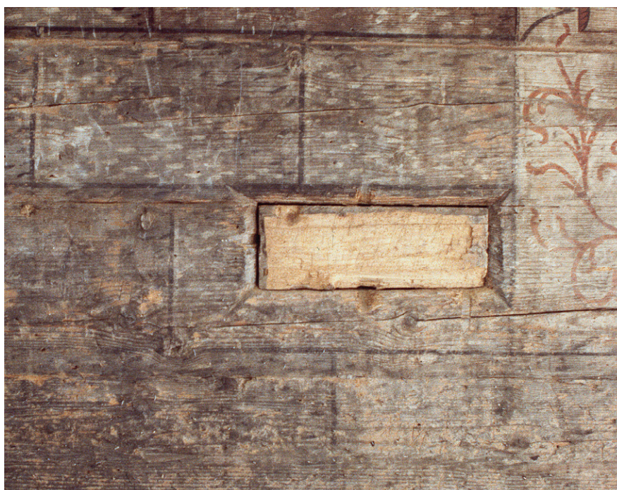
Abb. 31: Fensterluke in der Trauffassade von Haus Hauptstrasse 6 in Menzingen (Kat. 4), 1423d; die Öffnung befindet sich auf der Höhe eines Binnenwandvorstosses.
