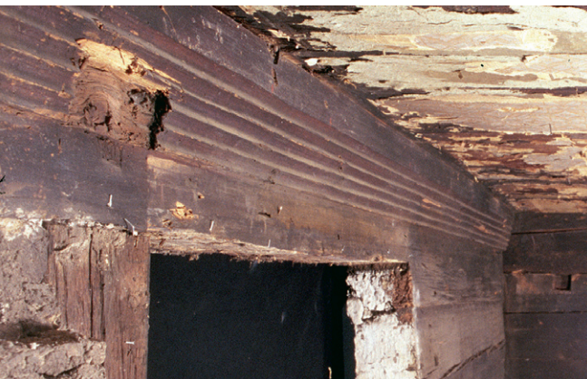
Abb. 116: Konsolgesims bei der Bohllendecke in der Nebenstube von Haus Dorfstrasse 17/19 in Walchwil (Kat. 23), 1580d.
