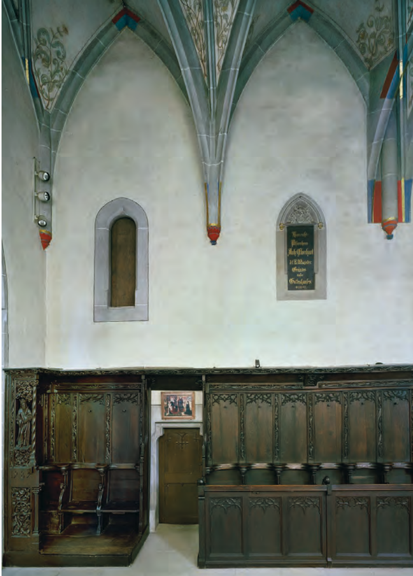
| Abb. 83 Zug, St. Oswald. Kapelle von 1478–1483 (Anlage I). In der Nordmauer des Altarhauses öffnete sich einst das Läuterfenster vom ersten Turmgesschoss in den Altarraum (links). Von Süden.
