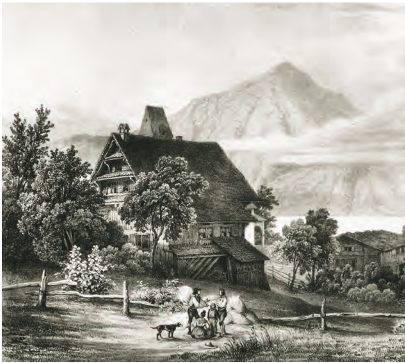
| Abb. 250 Walchwil, St. Johannes der Täufer. Ansicht von 1836. Damals besass der Kirchturm noch das wohl ursprüngliche Käsbissendach (erkennbar im Hintergrund hinter dem Bauernhaus).
