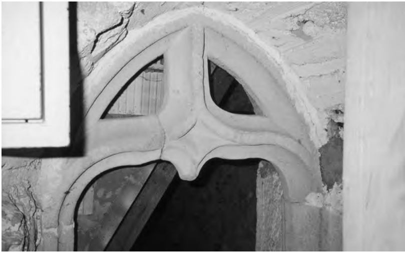
|Abb. 117 Steinhausen, St. Matthias. Kapelle von 1509–1511 (Anlage III). Schallöffnung in der Südmauer des Turmes (Innenseite).
