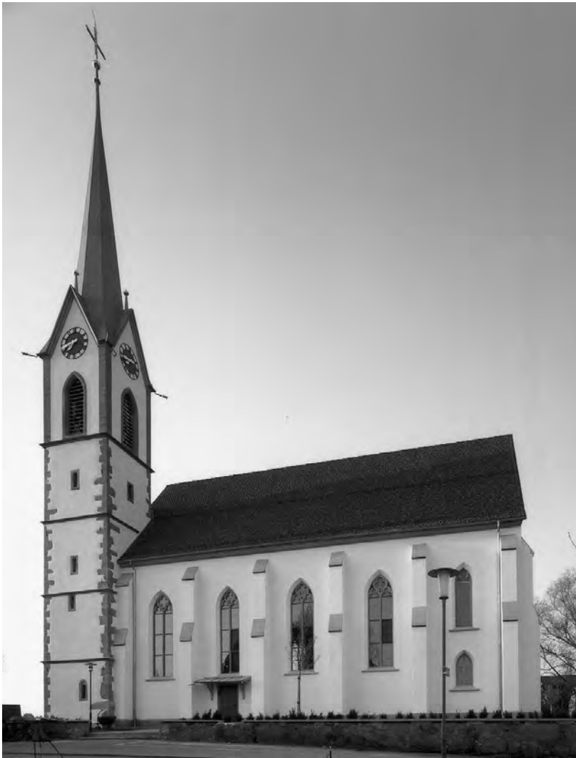
|Abb. 186 Oberrüti (Rüti), St. Rupert. Kirche von 1864/65 (Glockengeschoss von 1883). Ansicht von Norden.
