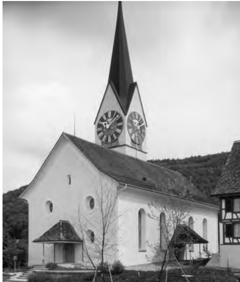
| Abb. 108 Hausen am Albis, ehemals St. Silvester. Kirche von 1751 (Anlage III; Glockengeschoss von 1905). Ansicht von Süden.
