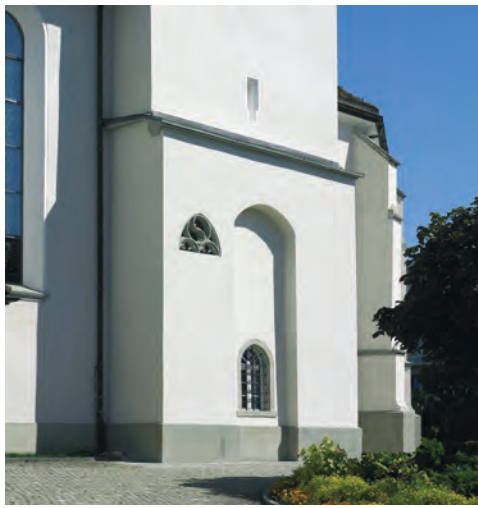
|Abb. 147 Menzingen, St. Johannes der Täufer. Kirche von 1477/78–1480. Südfassade des Turmes, Ansicht von Südwesten. Der untere Bereich lag ehemals im Innern der Kirche. Im Bogenfeld des einstigen Läuterfensters ist ein Masswerk eingesetzt (nach der Restaurierung von 2007).
