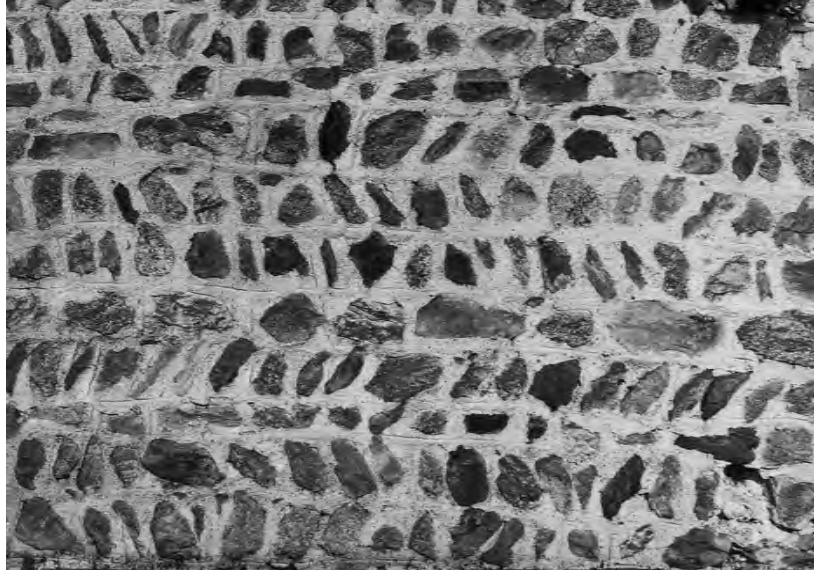
Abb. 28 Risch, St. Verena. Kirchen des 13./14. Jahrhunderts (Anlagen IV/V). Romanisch beeinflusstes, in Form von Handquadern geritztes und sichtbar belassenes Pietra-rasa-Mauerwerk des sicher nach 1288, schätzungsweise zwischen 1300 und 1320 entstandenen Turms.
