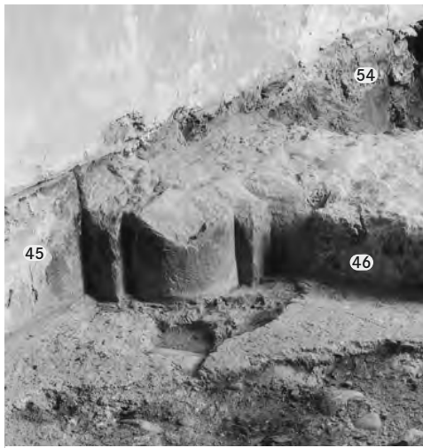
| Abb. 97 Baar, St. Martin. Kirche um 1360 (Anlage VIII). Gewölbedienst in der Nordostecke des Altarraums. Von Südwesten. Für die Positionsnummern vgl. Legende zu Abb. 90, S. 131.
