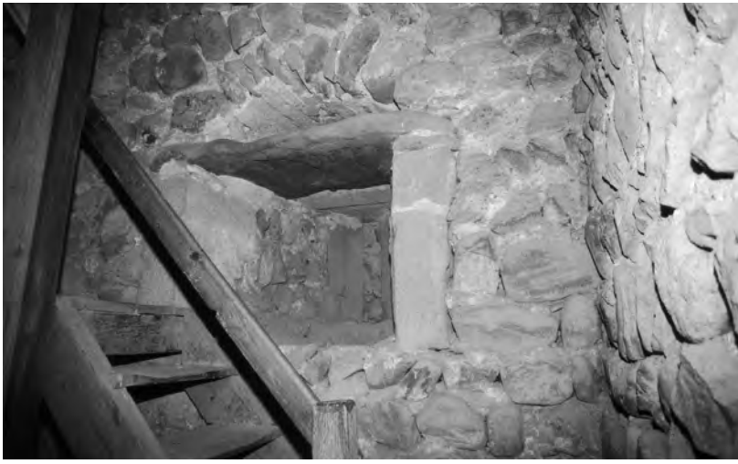
| Abb. 171 Oberägeri, St. Peter und Paul. Kirche des 13./14. Jahrhunderts. Fenster und Mauerwerk des Turmes (Innenseite).
