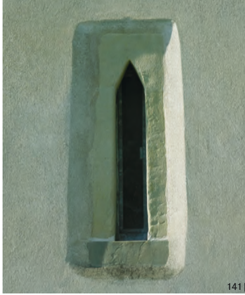
|Abb. 141 Meierskappel, St. Maria. Fenster in der Nordmauer des Turmes (Aussenseite).
