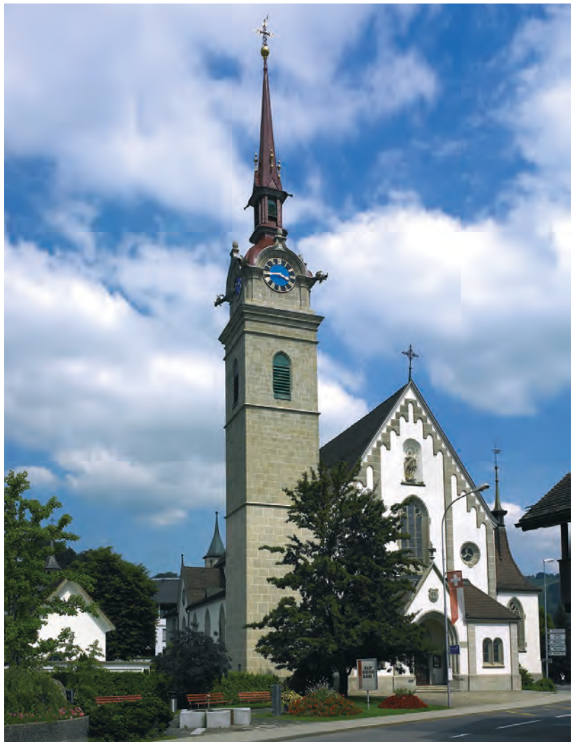
Abb. 168 Oberägeri, St. Peter und Paul. Kirche von 1905–1908. Ansicht von Nordwesten.
