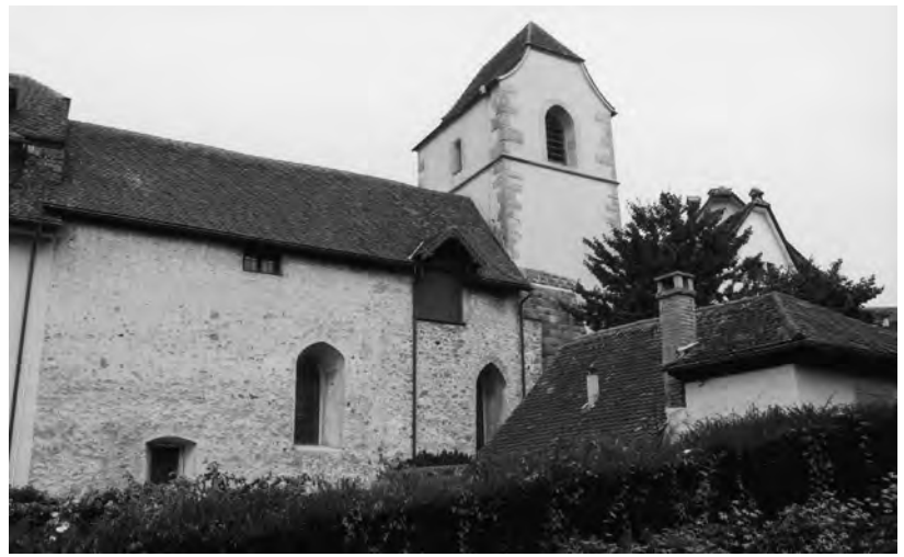
Abb. 79 Zug, Kapelle Unserer Lieben Frau (Liebfrauenkapelle). Ansicht von Südwesten der einst nicht befensterten Wehrmauer und des Chorturms von 1432/33 mit dem Glockengeschoss des 15./16. Jahrhunderts.
