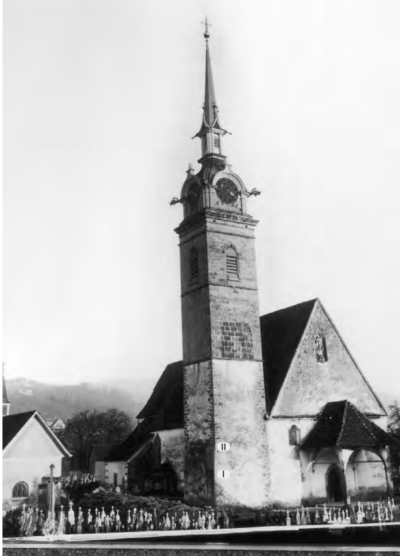
[Abb. 169 Oberägeri, St. Peter und Paul. Kirche von 1492/93, vor dem 1905 erfolgten Abbruch. Von Nordwesten. I An dieser Stelle fehlen Eckquader, II Rücksprung an der Nordmauer.
