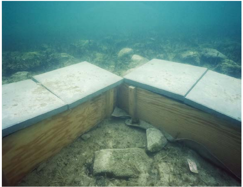
Abb. 41 Cham-Eslen. Verbessertes Profilschutz 2005: Ein Geotextil (in Bildmitte am Seegrund vor dem Profil sichtbar) und Bretter schützen das Profil, die Profilkante ist zusätzlich mit Gartenbetonplatten abgedeckt.
