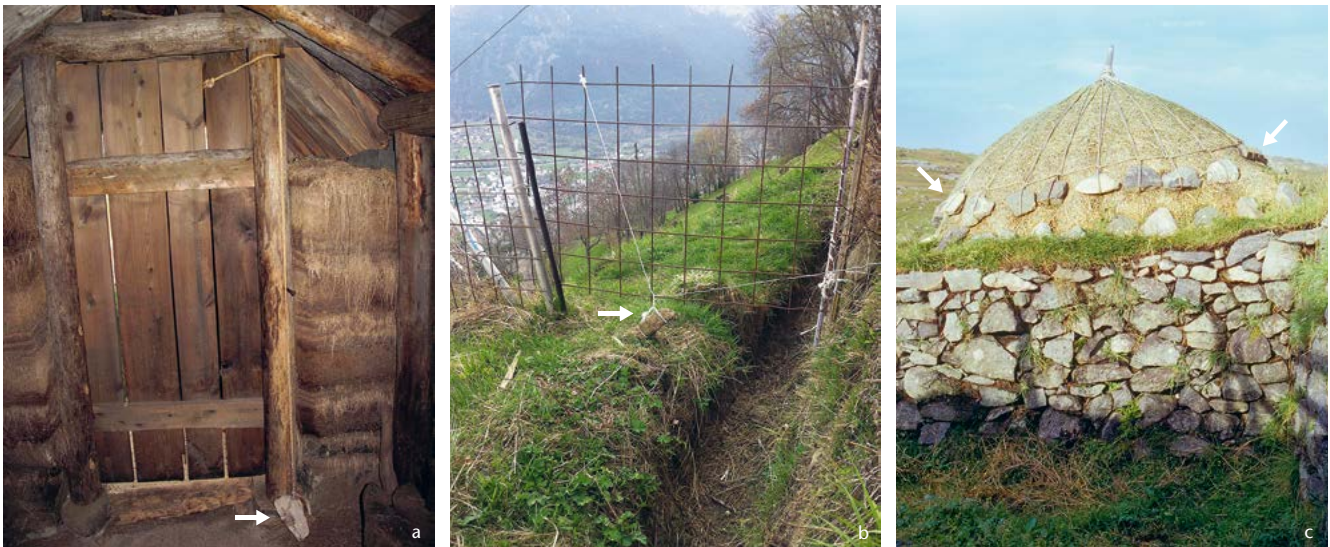
Abb. 216 a Schliessmechanismus einer Tür mit Türgewichtsstein (die Spannung der Schnur sorgt dafür, dass der Stein die Türe im geschlossenen Zustand fixiert, ihre Öffnung aber erlaubt und so quasi eine Feder ersetzt) im Freilichtmuseum Laugarhóll, Island, fotografiert 2013. b Schliessmechanismus eines Weidegatters durch einen Gewichtsstein bei Egga nahe Naters VS, fotografiert 2014. c Traditionelle Dachbeschwerung mittels massiver Steinblöcke im Freilichtmuseum The Garrannan Blackhouses, Isle of Lewis, GB (Schottland), fotografiert 1995.
