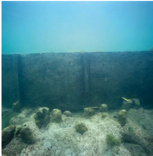
Abb. 38 Cham-Eslen. Die temporären Erosionsschutzmassnahmen nach der Grabungsetappe 1998/99 bestanden aus mit Kantenhölzern befestigten, senkrecht aufgestellten Brettern, die das Profil und die Schichten bis zur nächsten Grabungskampagne schützen sollten.
