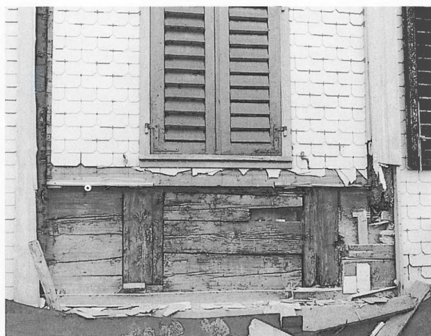
Abb. 14 Oberägeri, Haus Gerbe. Mittelteil der Ostwand aussen, Blick Richtung Westen. Unterhalb des (1991) aktuellen Fensters die Türpfosten des ursprünglichen Einganges.
