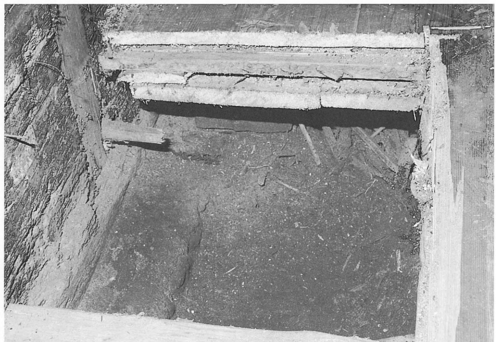
Abb. 25 Oberägeri, Haus Gerbe. Erdgeschoss, nicht unterkellertes Teil; Blick gegen Osten an die Innenseite der Nordwand unweit östlich der Nordwest-Ecke. Erkennbar sind die Blocks substanz (links) und die Oberkante der Steinmauer, auf der diese aufsitzt. Oben und rechts die verschiedenen Schichten der Fussbodenbretter. Es fehlt eine Bodennut.
