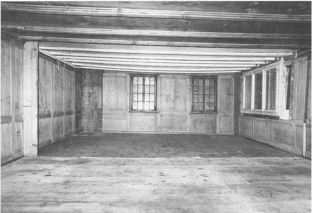
Abb. 16 Oberägeri, Haus Gerbe, gute Stube im Erdgeschoss. Blick auf die Ostwand mit partiell freigelegter Blockwand (Mitte links) und der originalen Balkendecke, die (1991) im hinteren – östlichen – Teil weiss überstrichen war. Der originale Blockbau war an allen Wänden mit Täferung versehen, die zusammen mit den zwei Sprossenfenstern in der Ostwand dem 18. Jahrhundert angehören. Der Renovierung von 1962 entstammen die Fenster der Südwand (rechts) sowie der Pfosten einer leichten Trennwand (links), die knapp drei Jahrzehnte die Stube in einen Ost- und Westteil gliederte. Dies bedingte auch die unterschiedliche Erscheinung der erhaltenen modernen Fussbodenteile.
