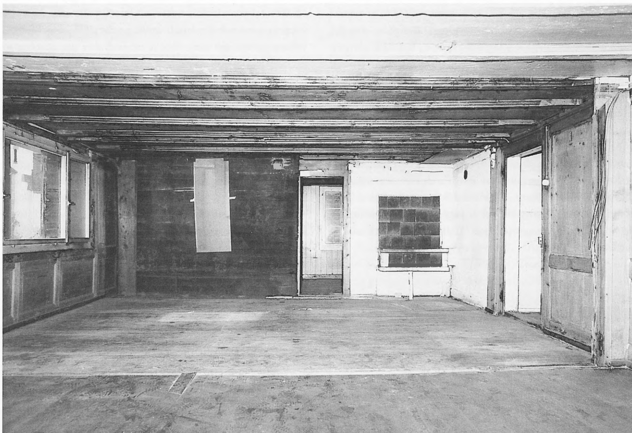
Abb. 17 Oberägeri, Haus Gerbe, gute Stube im Erdgeschoss. Blick auf die Westwand, wo das Täfer zu Untersuchungsbeginn fehlte; mit den Ofenresten vor der gemauerten Kaminwand (Mitte rechts) sowie (Mitte links) an der originalen Blockwand ein von uns angebrachter Holzverschlag zum Schutz des Wandbildes.
