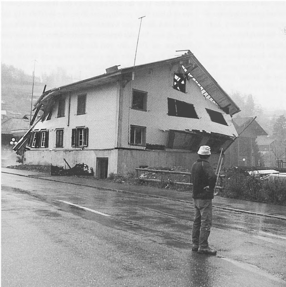
Abb. 30 Oberägeri, Haus Gerbe. Beginn des Abbruchs im Jahr 1991; Blick von Südwesten.
