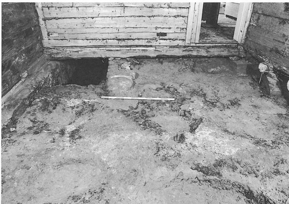
Abb. 26 Oberägeri, Haus Gerbe. Erdgeschoss, Blick von der Nordwest-Ecke gegen Osten, oben und rechts jüngere Trennwände. Am rechten Ende der Messlatte die Feuerstelle, unten (die bereits ausgehobene) Grube. Mitte links der Treppenabgang gegen Osten mit südlicher Treppenwange.
