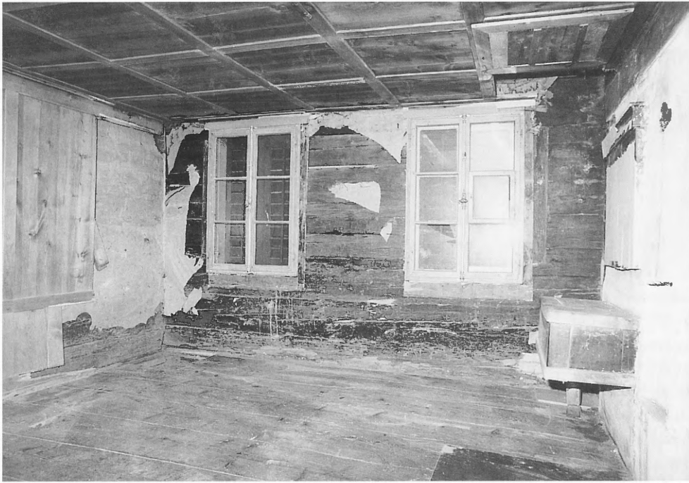
Abb. 15 Oberägeri, Haus Gerbe, Erdgeschoss. Blick gegen Osten in die ursprüngliche Speisekammer, Zustand 1991. In der Bildmitte die moderne Befensterung, neben bzw. unterhalb der die Reste des ursprünglichen Blockbaues sichtbar sind (dunkle Hölzer). Links, oben und unten im Bild die 1991 angebroffene Wand-, Decken- und Boden-ausstattung. Rechts im Bild die nachträglich aufgemauerte Kaminwand mit Ofenresten.
