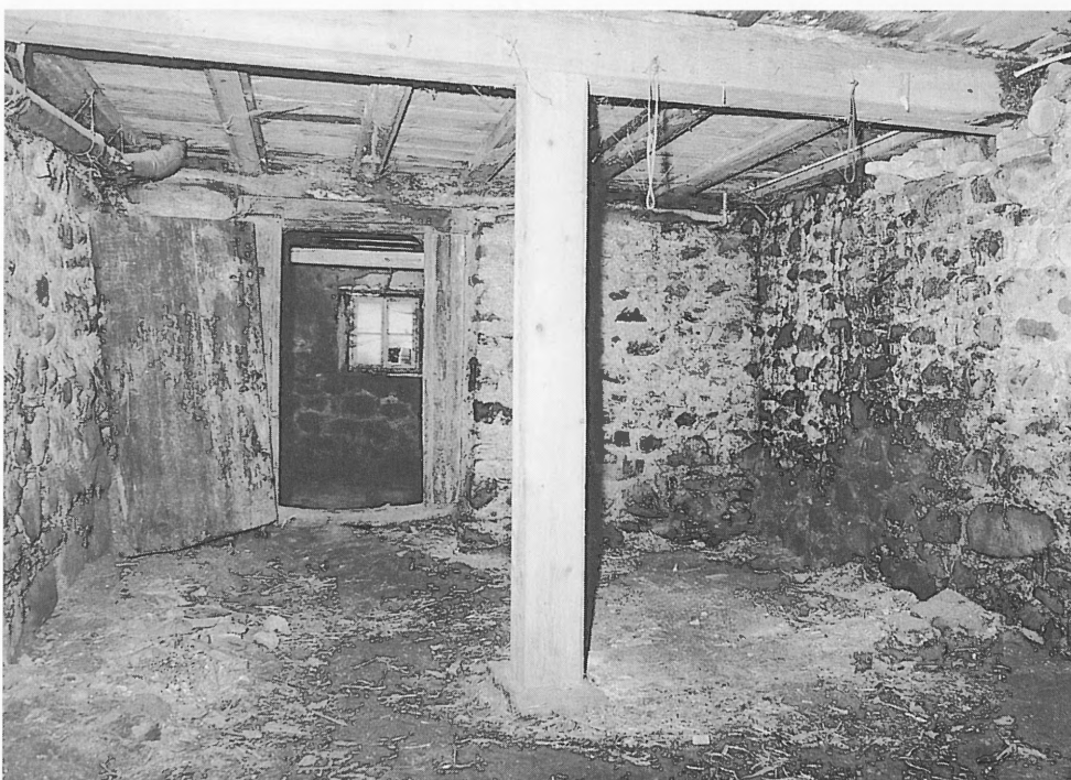
Abb. 39 Oberägeri, Haus Gerbe. Blick in die Südwest-Ecke von Keller 3. Neben dem originalen Mauerwerk sind die jüngere Decken- und Stützkonstruktion sowie moderne Versorgungsleitungen erkennbar.
