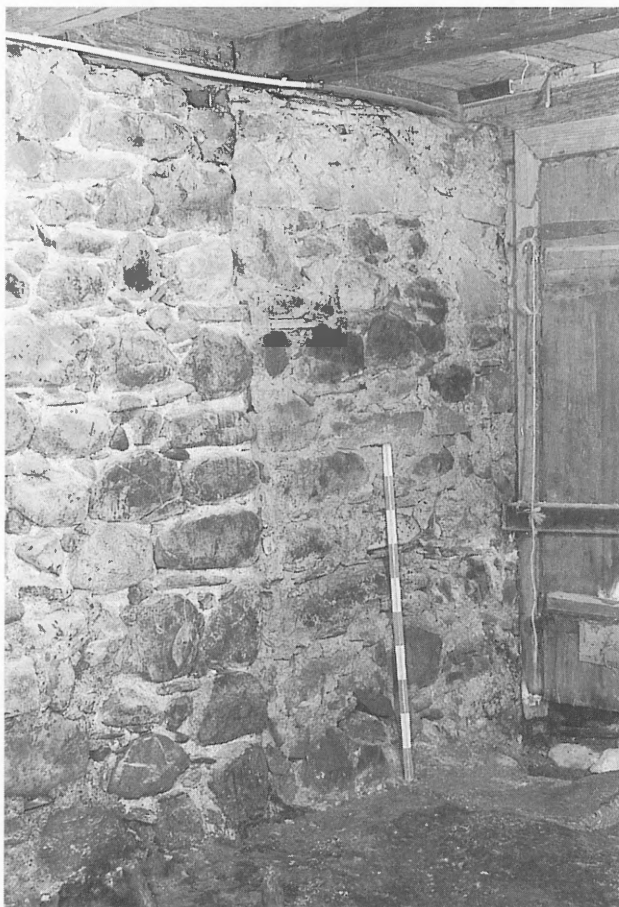
Abb. 12 Oberägeri, Haus Gerbe. Keller 3, Blick gegen Norden in die Nordwest-Ecke. In der Mitte der zugemauerte originale Abgang von Osten her in den Keller, rechts die jüngere (Aussen)tür.
