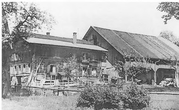
Abb. 11 Oberägeri, Haus Gerbe. Foto aufgenommen vor 1962, das den Blockbau noch unverkleidet zeigt. Blick von Südosten; das Sockelgeschoss an der Südseite (links) wird unterhalb der Erdgeschoss-Fenster von einem überdachten Brennholzstapel verdeckt.
