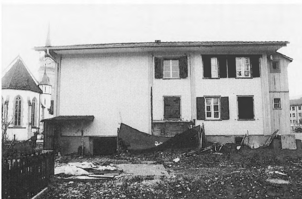
Abb. 1 Oberägeri, Haus Gerbe. Ansichten vom Zustand 1991. Oben Blick von Nordwesten; unten Blick auf die Ostseite, links im Hintergrund die katholische Pfarrkirche.
