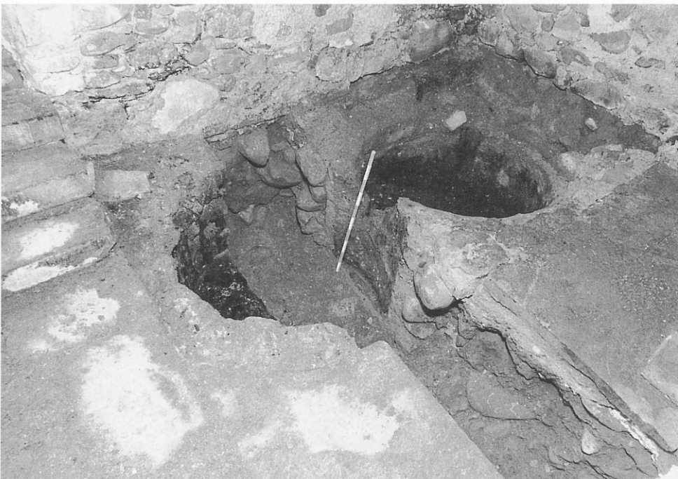
Abb. 33 Oberägeri, Haus Gerbe. Blick Richtung Nordwesten in Keller 1. Sichtbar sind der 1991 angetroffene Boden aus Sandsteinplatten und die nachträglich errichtete Treppe (links), die zwei ausgenommenen Gerbergruben mit zugehöriger Tonabdichtung und Hinterfüllung aus Steinen sowie der Ost-West-Schnitt (vgl. Abb. 31 und 32).
