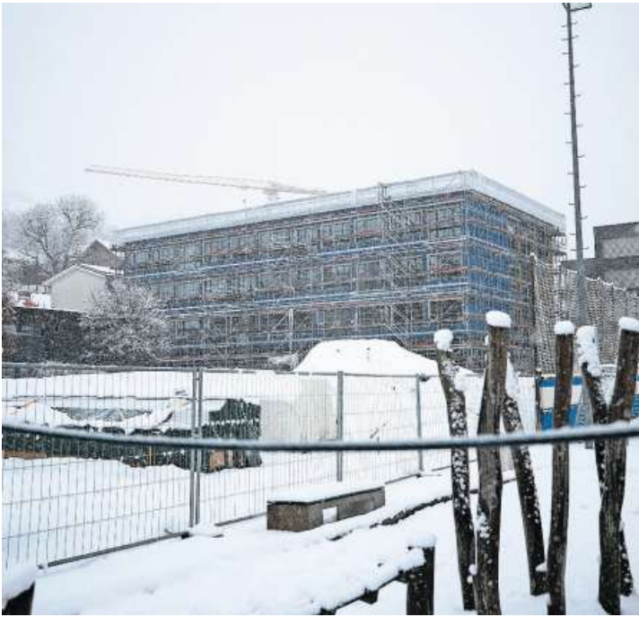
Das neue Schulhaus Mitte ist fast fertig. Nun werden die Gebäude Acher Ost und Nord saniert. Bild: Stefan Kaiser (Unterägeri, 8. Dezember 2021)
