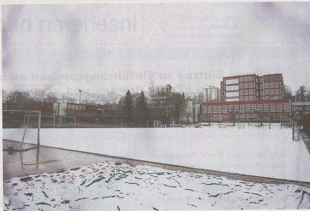
Die neue Sporthalle in unmittelbarer Nähe zur bestehenden Turnhalle wird auf dem Hartplatz zu stehen kommen. Der Bau kostet über 18 Millionen Franken.
