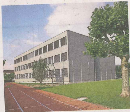
Die bestehende Schulanlage der Kanti Zug ist mit dem Schulraumprovisorium um 18 Unterrichtszimmer ergänzt worden. z.V.g.
