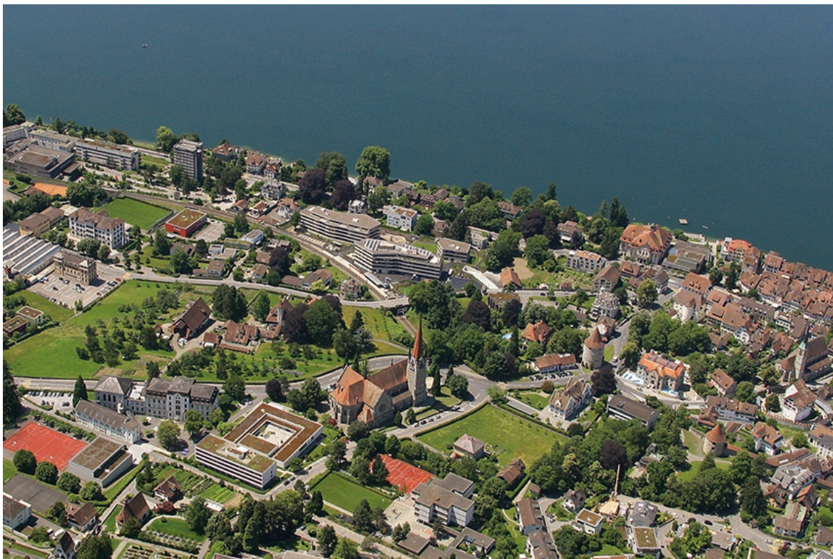
Abbildung 1: Blick auf das rechteckige Gebäude der PH Zug (neben der Kirche St. Michael)
