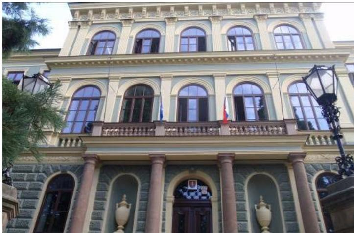
In den letzten Monaten wurde die Fassade der Fachmittelschule für das Forstwesen vom Sockel bis zu den Kaminen renoviert und erstrahlt jetzt in neuem Glanz. Das 1892 errichtete Gebäude steht unter nationalem Denkmalschutz. Abgebröckelter Stuck wurde ersetzt, die Fassade neu gestrichen mit Isolationsfenstern versehen. 85 % der Kosten in der Höhe von 309'000 € übernahm der EU-Fonds für Regionalentwicklung, 10 % der slowakische Staat und 5 % der Schulträger, die Verwaltungsregion Banská Bystrica.
