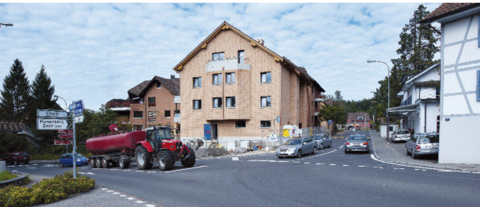
Das neue Wohn- und Geschäftshaus.
