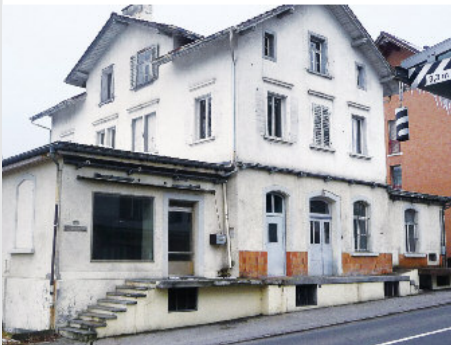
Das alte Käsereigebäude vor dem Abbruch.
