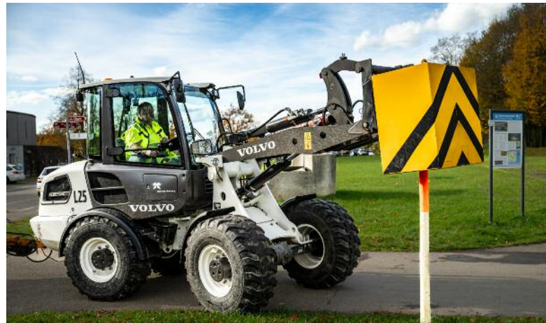
Die Schneepfähle werden eingeschlagen.
