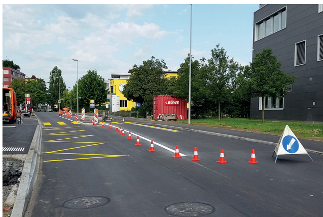
Sanierung Rothusstrasse im Jahr 2017
