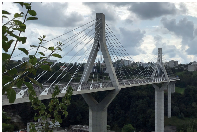
Die neue Poya-Brücke in Freiburg
