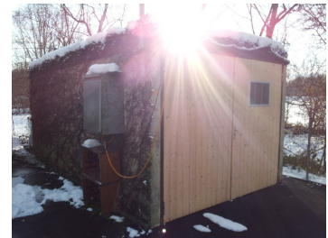
Kadaversammelstelle Giessen | Giessen | Hünenberg
