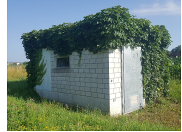
Rückhaltebecken Rothus | Rothus | Hünenberg
