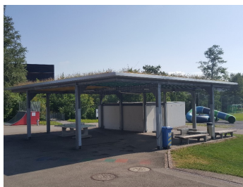
Garage und Pausenunterstand Kemmatten | Huobstrasse 30 | Hünenberg
