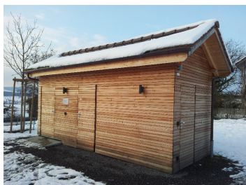
WC-Anlage Wiräben | Wiräben | Hünenberg
