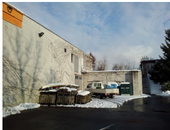
Pumpwerk und Lager Giessen | Giessen | Hünenberg
