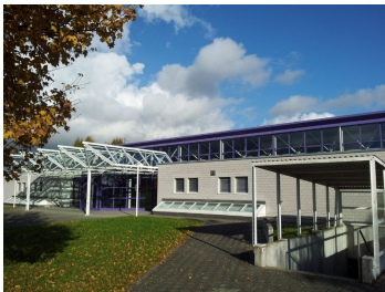
Dreifachturnhalle Ehret | Zentrumstrasse 10 | Hünenberg
