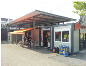
WC-Anlage und Verkaufspavillon Dersbach | Dersbachstrasse | Hünenberg See
