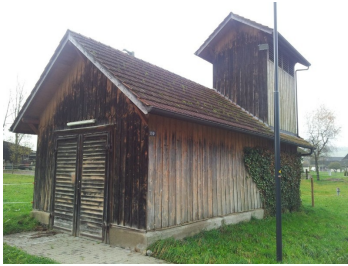
Feuerwehrdepot Stadelmatt | Stadelmatt | Hünenberg
