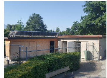
Strandbad - Technikgebäude | Dersbachstrasse | Hünenberg
