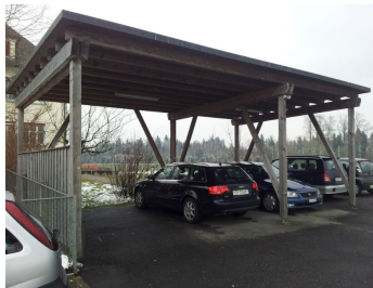
Autounterstand Matten | Matten 16 | Hünenberg
