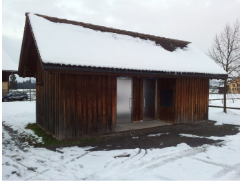
WC-Anlage / Trafostation St. Wolfgang | St. Wolfgang | Hünenberg
