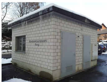
Pumpwerk Burg | Drälikerstrasse | Hünenberg
