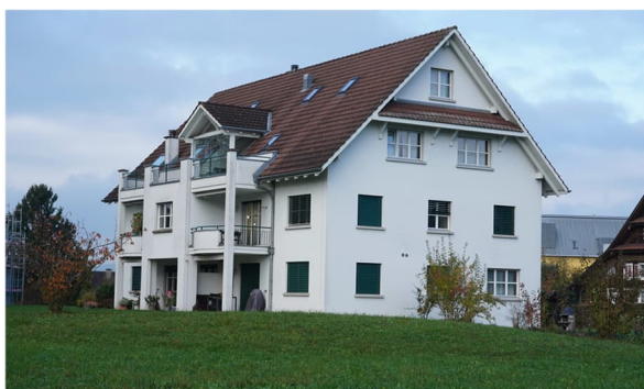
Abb. 7: 5-Familienhaus im Baubereich 2, Aufnahme Oktober 2024
