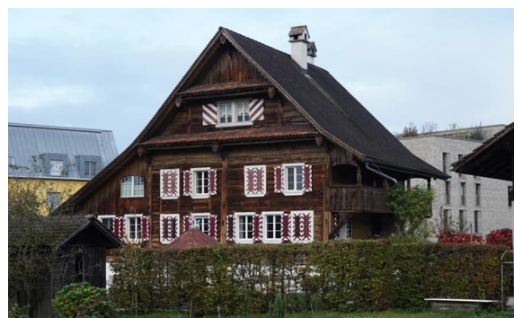
Abb. 8: Altbau 69a, Aufnahme Oktober 2024
