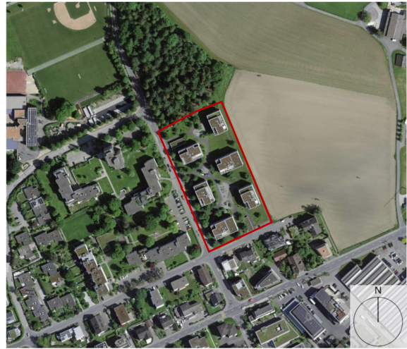
Abb. 2: Luftbild (map.geo.admin.ch, Stand 2022), Perimeter rot gekennzeichnet
