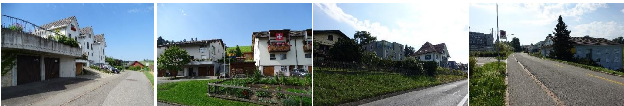
Abb. 7: Beispiele von strassenbegleitenden Bauten in der Gemeinde
