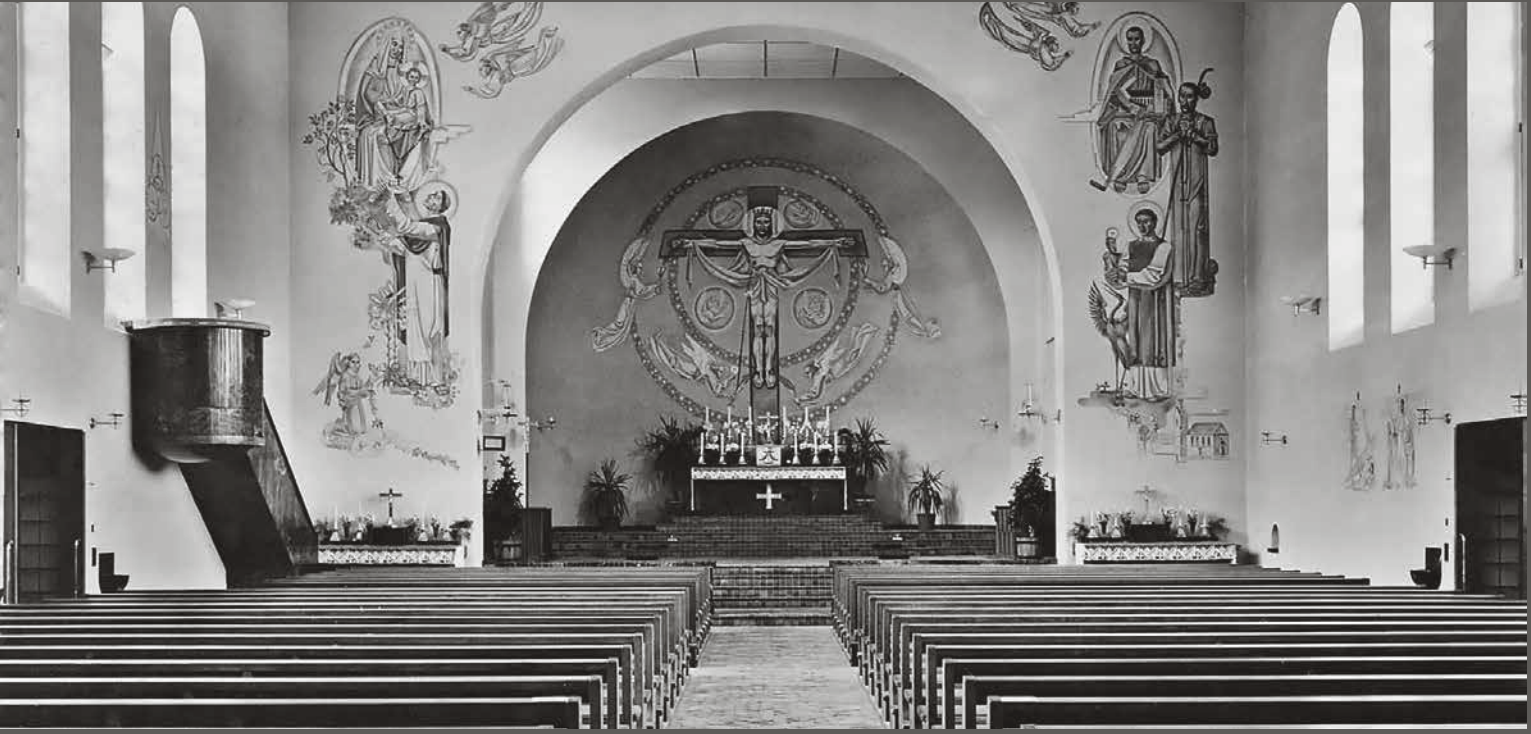
Die durch den katholischen Kultusverein erstellte Kirche wurde während der Weltwirtschaftskrise durch Subventionen von Bund, Kanton und Gemeinde sowie die Geldsammlungen des damaligen Kaplans von Holzhäusern, Albert Zollet, finanziert. Architekt war Josef Steiner von Schwyz. Der Rohbau inkl. Turm wurde innert 51 Tagen erstellt. Albert Zollet wurde am Einweihungstag vom 25. September 1938 zum ersten Pfarrer von Rotkreuz installiert. Die Glocken läuteten aber schon zuvor erstmals am 1. August 1938.
