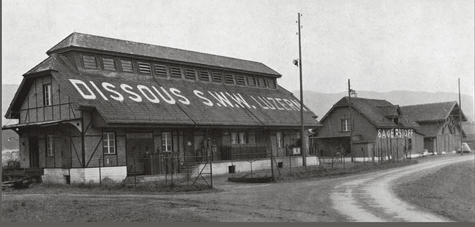
Das «Sauerstoff- & Wasserstoff-Werk Luzern AG» baute 1926 in Rotkreuz das Acetylen-Dissous-Werk als Ersatz für die in Horw 1923 durch eine Explosion zerstörte Fabrik. Acetylen gas braucht zu seiner Erzeugung Wasser und Calciumkarbid. Das nötige Wasser bezog das Werk aus dem parallel zur Strasse fliessenden Kanal, der um 1890 herum zur Entwässerung der Holzhäuserhöfen erstellt worden war. 1966 wurde die Produktion in Rotkreuz eingestellt.
