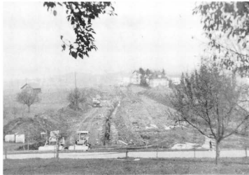
Die Liegenschaft Rotkreuzhof wird durch die Westumfahrung entzweigschnitten.
