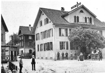
Gasthaus Rothkreuz, erbaut ursprünglich als Zollhaus im Jahre 1836 durch den Binzmüller Michael Degen.
