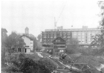
Beginn der Bauarbeiten an der Westumfahrung
