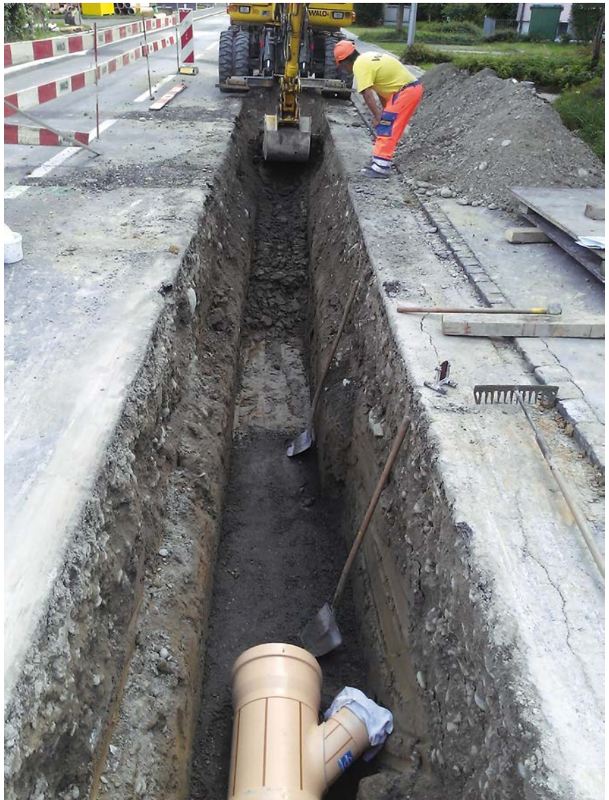
Abbildung 2: Realisierung Trennsystem Meierskappelerstrasse in Rotkreuz
