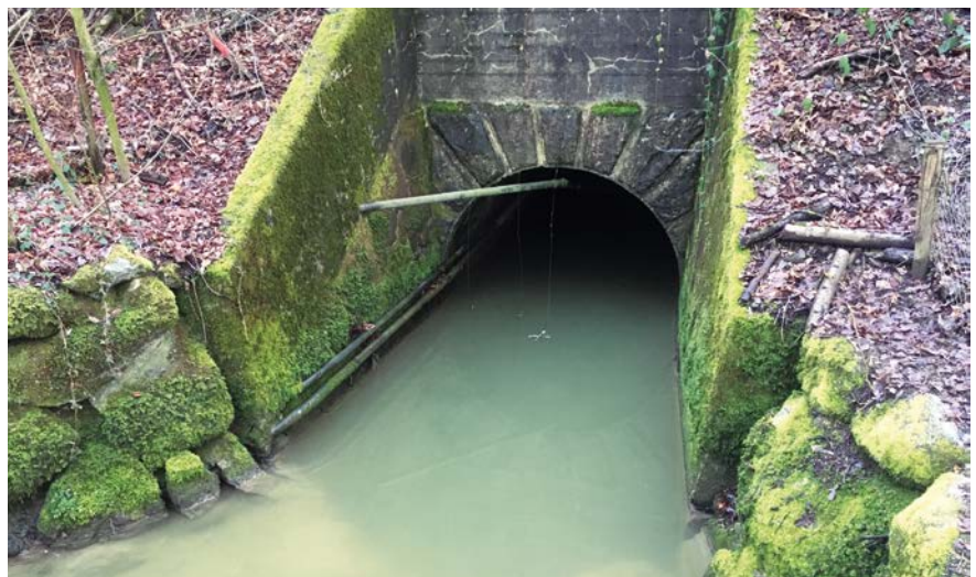
Abbildung 4: Durchlass SBB bei der Binzmüli
