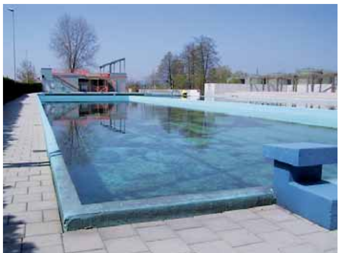
bestehendes Schwimmbecken, Schwimmbad Rotkreuz
