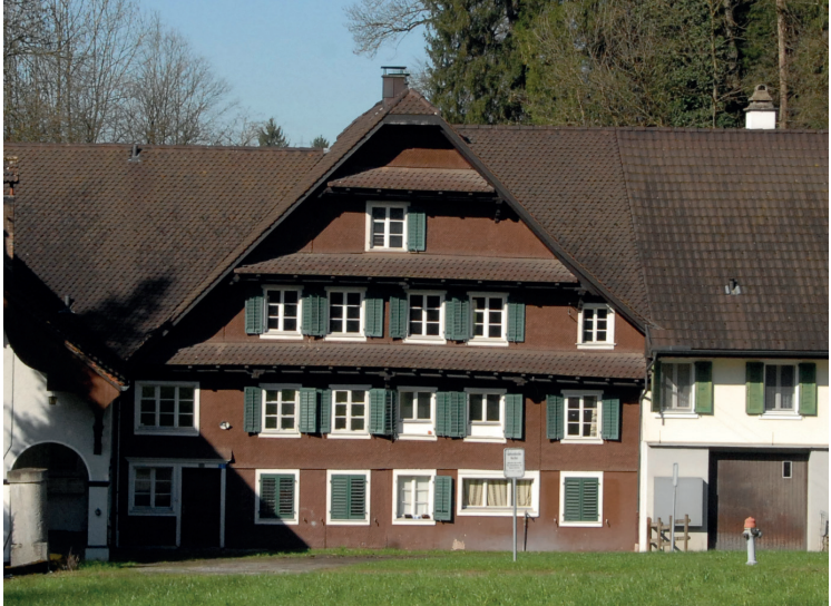
Ostfassade des Mittelhauses
