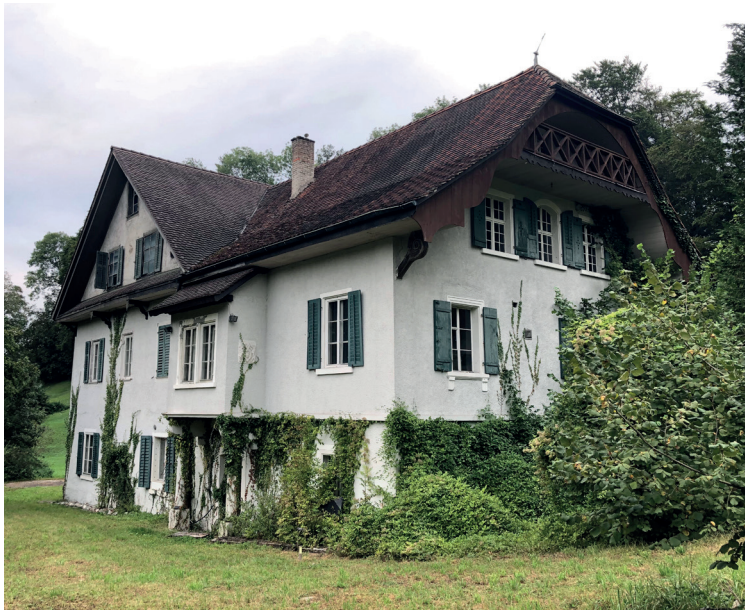
Mühlegebäude mit Süd- und Ostfassade
