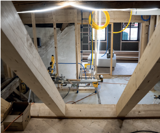
Die Sanierung erforderte Kreativität und erfolgte mit hohem Respekt für die alte Bausubstanz.
