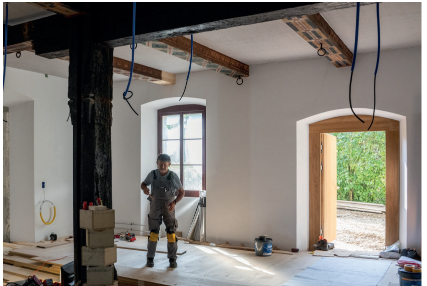
Im Untergeschoss des Mühlehauses wurde ein Naturschulraum realisiert, der für Schulklassen zur Verfügung steht.
