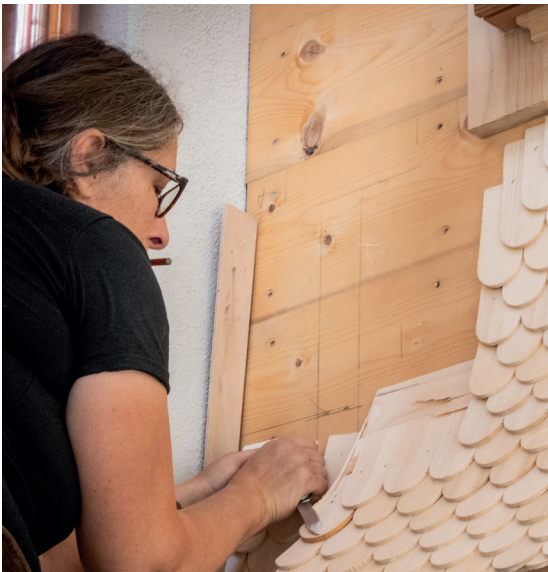
Das Mittelhaus wurde beidseitig mit handgefertigten Holzschindeln beschichtet.
