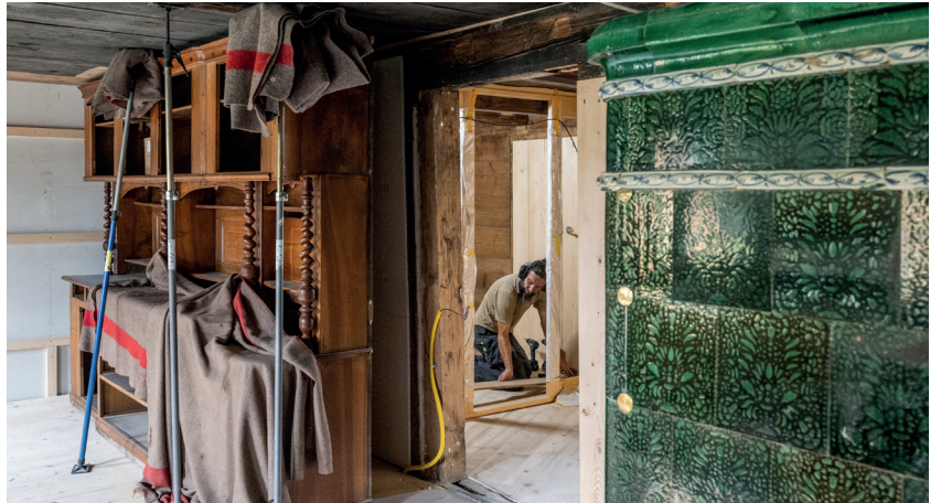
Im geschindelten Mittelhaus konnte das frühklassizistische Holzbüffet mit Intarsien von 1805 saniert und erhalten werden.
