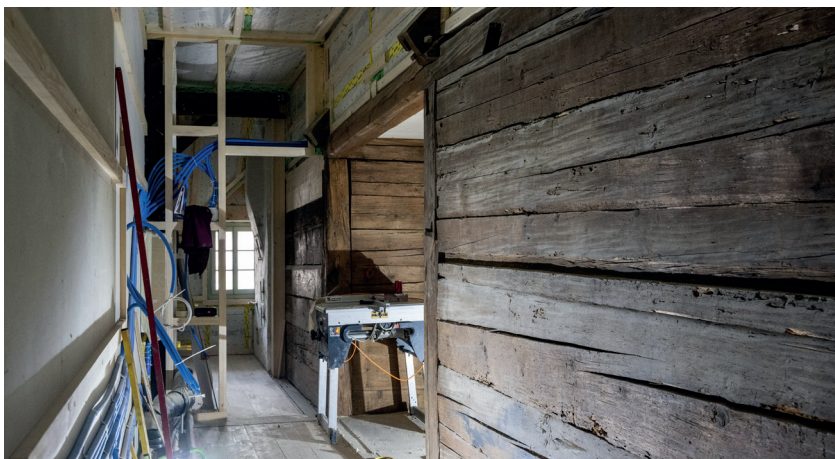
Mühle und Mittelhaus wurden mit moderner Haustechnik sowie mit zeitgemässen Nasszellen ausgestattet.
