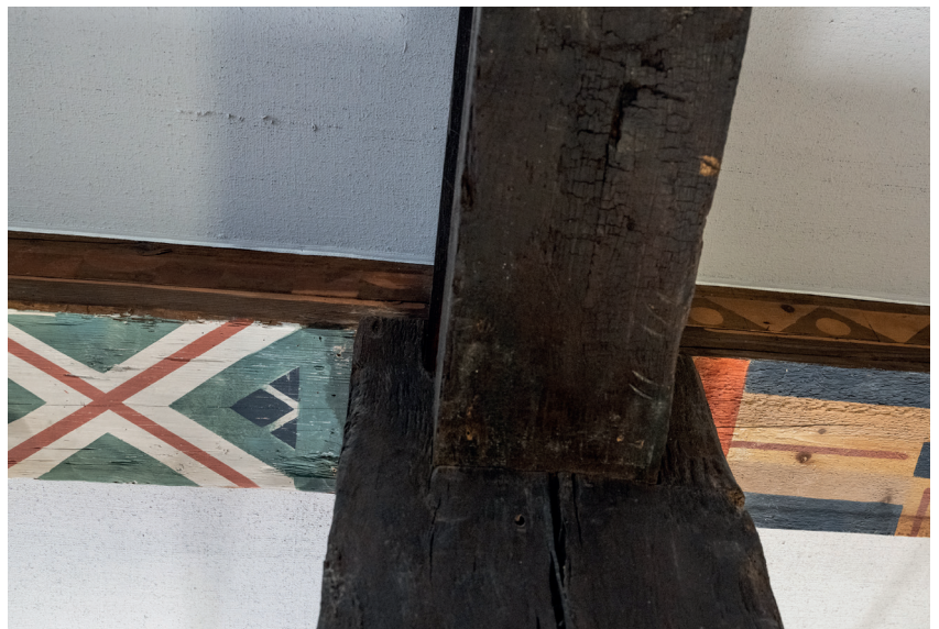
Starke Eichenholzträger im Mühlehaus sorgen im Verbund mit farbigen Querträgern für die nötige Statik.
