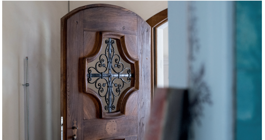
Historisch wertvolle Teile wie diese Türe mit kunstvollem Gitter wurden saniert und wieder ins Baudenkmal integriert.
