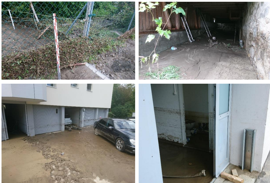
Abbildung 5: Links oben: Geschwemmte Äste im Maschendrahtzaun im Gebiet Obere Weid / Weihermatt; Rechts oben: Ablagerung von Feinmaterial in der Alten Sagi neben dem Durchlass Küntwilerstrasse; Links unten: Schlammablagerung und Spuren von stehendem Wasser an der Haldenstrasse; Rechts unten: Spuren von ca. 1m stehendem Wasser im Keller des Camaro-Block. (Foto: HOLINGER AG)
