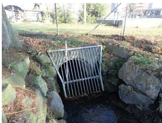
Abbildung 6: Rechen vor dem Durchlass Jungwacht /Sportplatz
