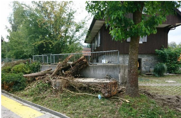
Abbildung 3: "Holzdepot" bei der Eindolung Waldhof. Grosse Mengen Schwemmholz wurden ins Siedlungsgebiet transportiert. (Foto: HOLINGER AG)
