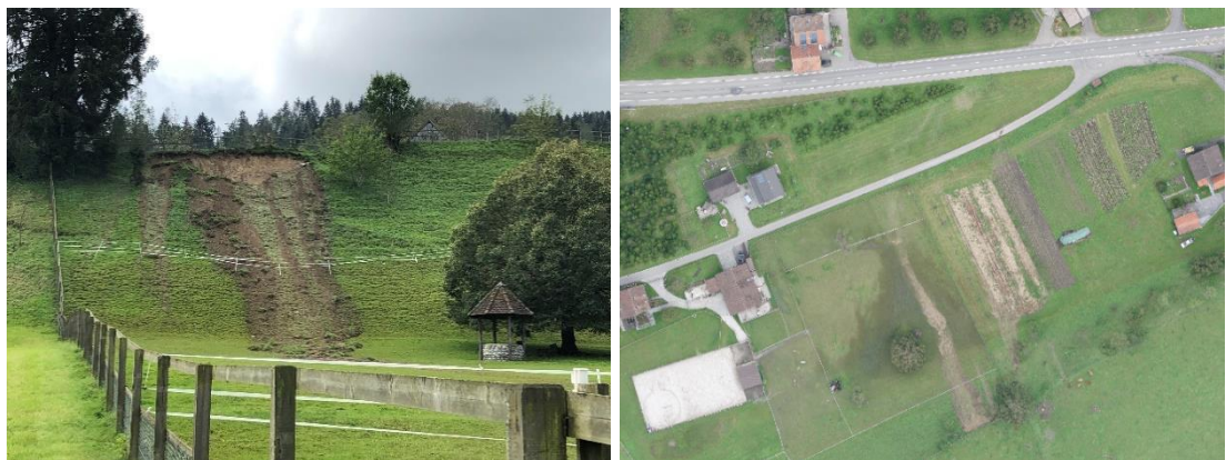
Abbildung 1: Rutschung im Gebiet Ibikon (Quelle Foto Kt. ZG, Luftbild [5])
