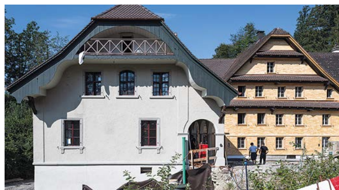
Blick auf das neu sanierte Kleinod
