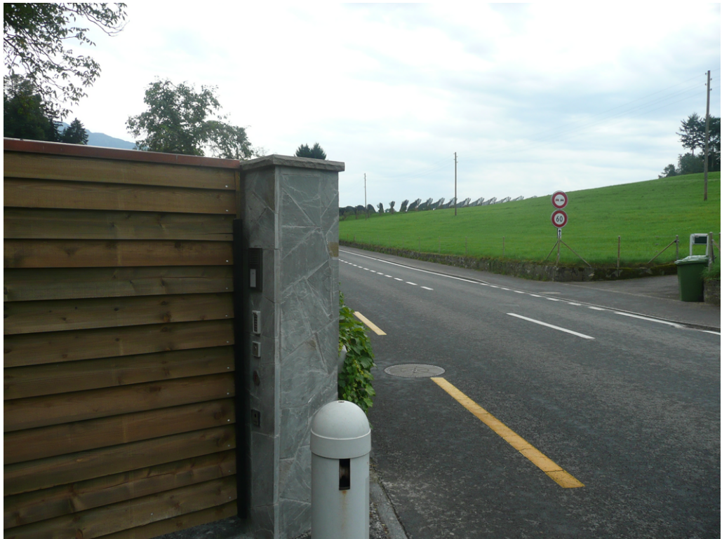
Abbildung 1: Mauer entlang Strasse (Baujahr 2009)
