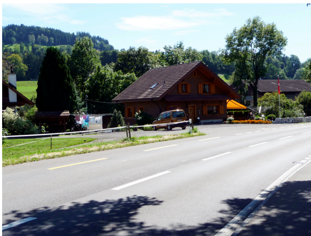
Abbildung 14: Zufahrt und Hauseingang Stöckli Sidler
