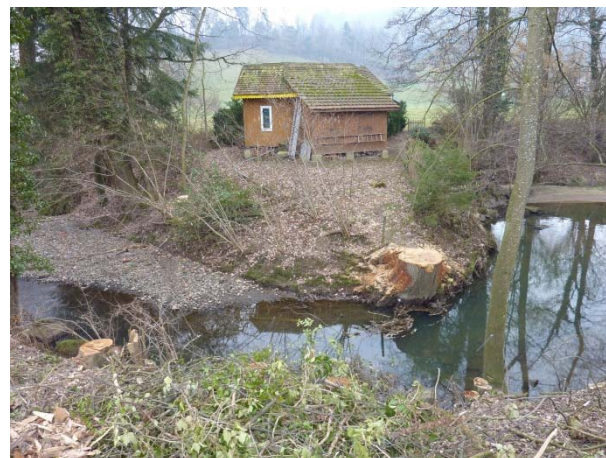
Abb. 3 Aabach im oberen Abschnitt mit markanten Kurven.
