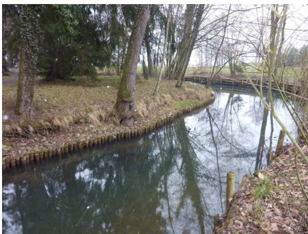
Abb. 4 Aabach im unteren Abschnitt im Rückstaubereich des Sees und mit Verbauung zum Schutz der Bäume.
