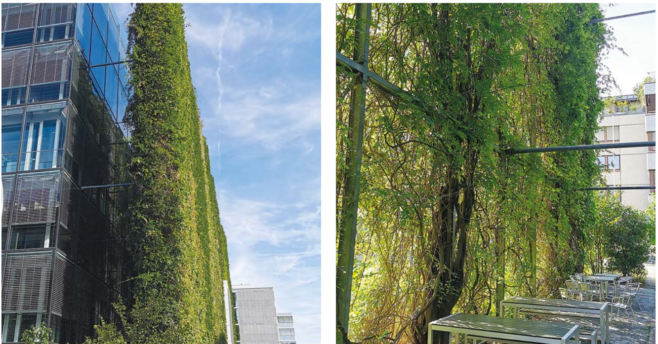
Beispiel vorgesetzte vertikale Fassadenbegrünung eines Geschäfts in Glattbrugg
