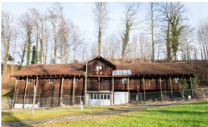
Sanierungsbedürftige Remise von Süden her
