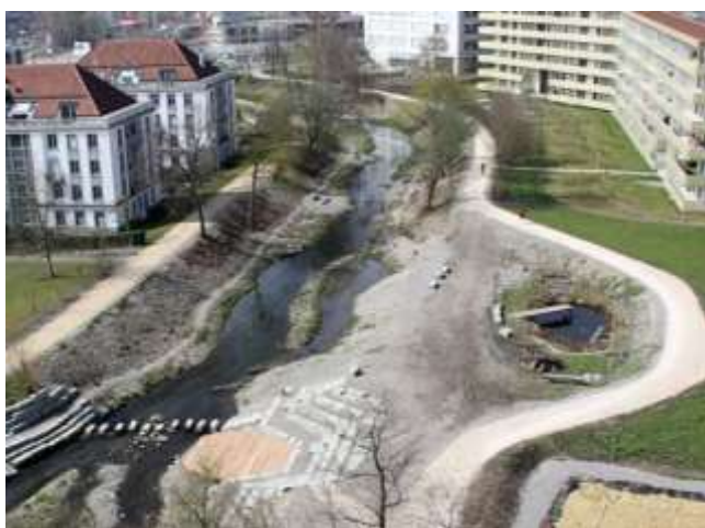
Von der Revitalisierung des gut 900 Meter langen Abschnitts des Chriesbachs in Dübendorf profitiert die Vielfalt an Tieren und Pflanzen. Aber auch Erholungssuchende fühlen sich am wiederbelebten Bachlauf wohl.
