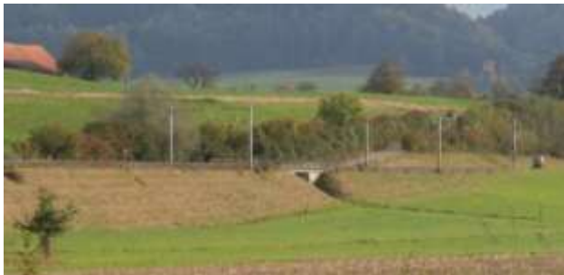
Südlicher Teil der Bahnböschung.
