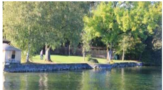
IST-Situation Badi Buonas. Das Ufer ist bis auf wenige schmale Zustiege mit einer Natursteinmauer verbaut.
