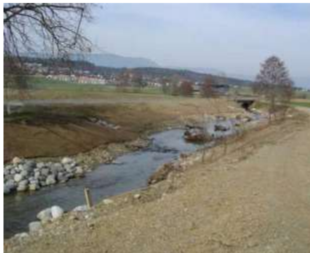
Der aufgewertete Mülbach in Kräilingen (SO) ist leicht geschwungen und hat eine Fliesstiefenvariation. Im Uferbereich wurden Steinanreicherungen als Nist- und Schutzplätze für Reptilien und Amphibien aufbereitet.
