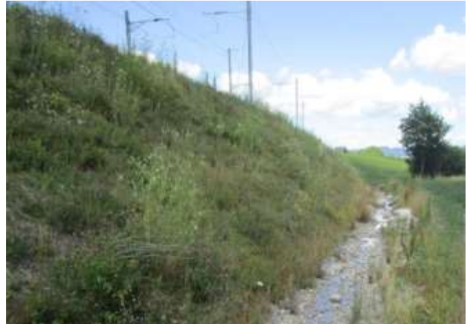
Neugestaltete Bahnböschung nach 2-Spurausbau südlich der Golfanlage Holzhäusern. Für den Untergrund wurde nur Sand und Kies, also mageres Material verwendet. Die Samenmischung einer Ruderalflora sorgt für einen typischen lückigen Bewuchs.
