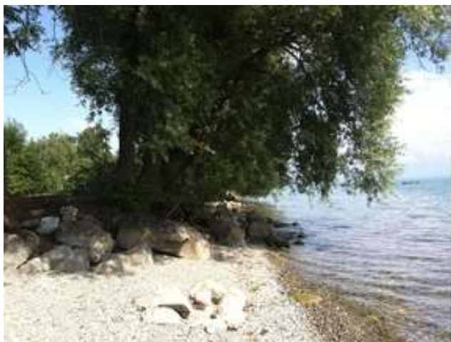
In Goldach (SG) wurde eine Blocksteinsicherung rückgebaut und mit Hilfe von Bühnen entstand ein natürlicher Kiesstrand.
