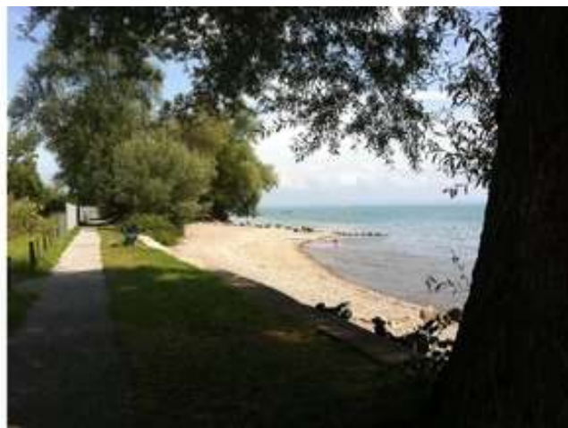
In Goldach (SG) wurde eine Blocksteinsicherung rückgebaut und mit Hilfe von Bühnen entstand ein natürlicher Kiesstrand.
