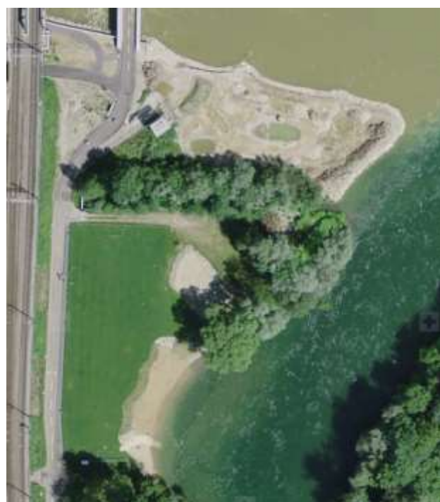
Luftbild Reusszopf Luzern: der nördliche Bereich ist als Lebensraum für Amphibienförderung gestaltet, im Süden wurde das unzugängliche Ufer abgeflacht und ist nun sogar für Kinder als ungefährlicher Badeplatz zugänglich.
