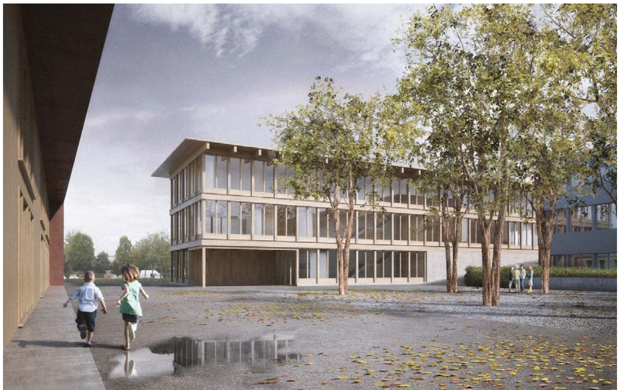
Abb. 2: Neubau West –Längsbau parallel zur Meierskappelerstrasse
