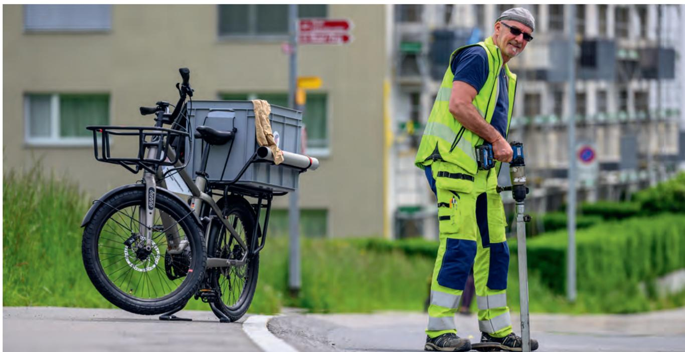
Mit dem praktischen Lastenvelo ist die Kontrolle der Schieber einfacher geworden.
