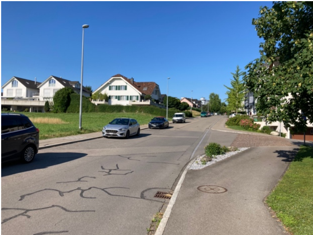
Abbildung 5: Bestehende Situation auf der Hasenbergstrasse
