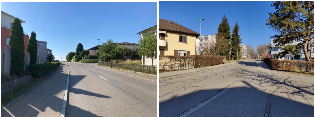
Abbildungen 7 und 8: Bestehende Situation auf der Knonauer- und Tellenmattstrasse
