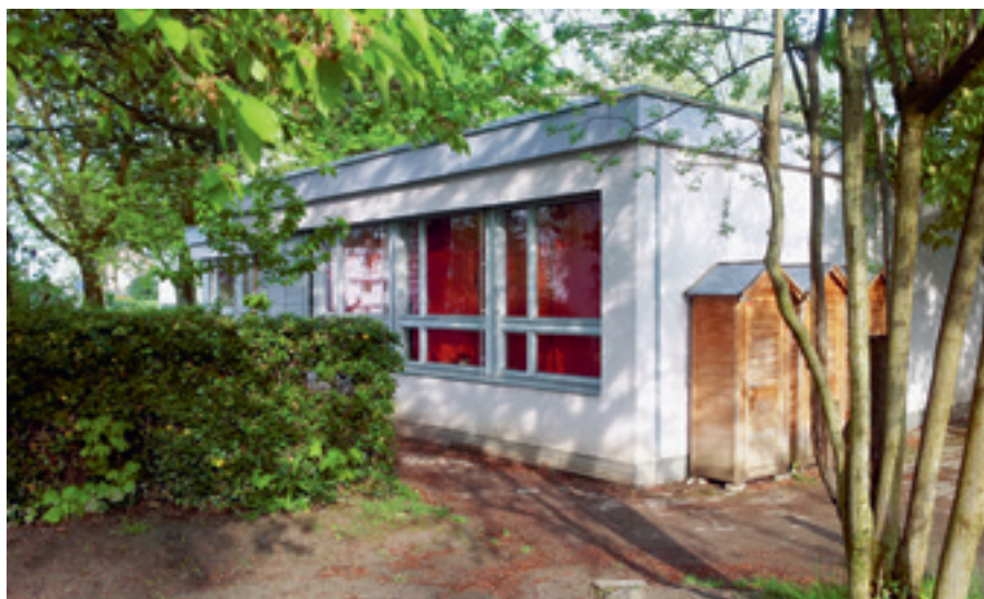
Bestehender Doppelkindergarten im Hasenberg
