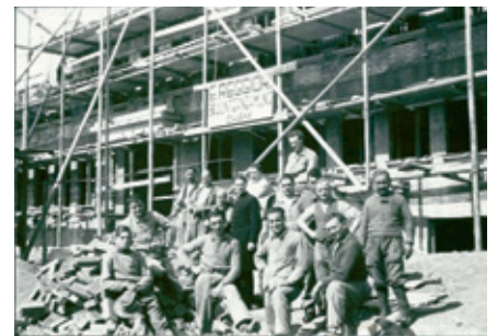
Baustellenaufnahme von 1936, Neubau Schulhaus Sunnegrund 1
