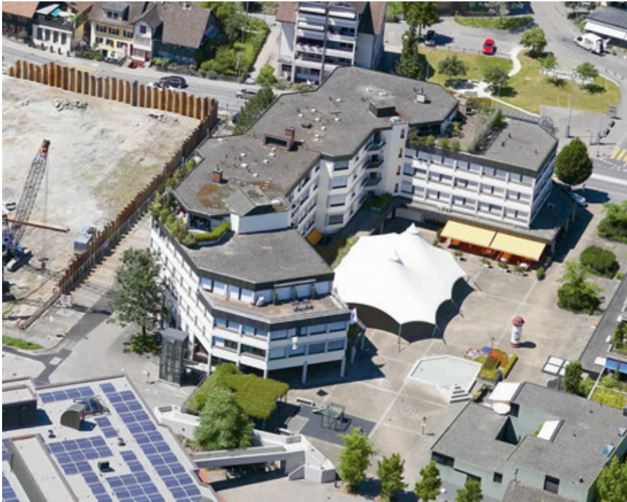
Luftaufnahme aus dem Jahr 2015 - Bahnhofstrasse 1 und 3 mit dem Dorfplatz
