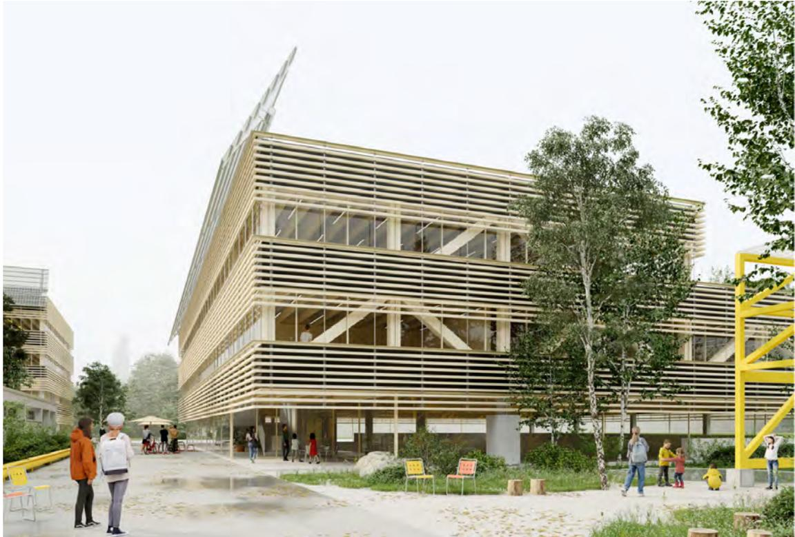
Für beide Bauten wird eine hybride Konstruktion vorgeschlagen. Die überirdischen Bauteile sind als reiner Holzbau gedacht. Die Tagesstruktur hat eine Konstruktion von 7 Holzfachwerkträgern, die raumhoch sind. Diese Elemente prägen auch das Fassadenbild. Auf der Südseite von Orpheus wird ein PV-Segel etwas zu sehr expressiv und überzeichnet an die Gebäudekante gerückt.
