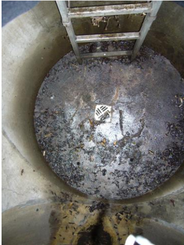
Sickerung mit Bodenablauf
