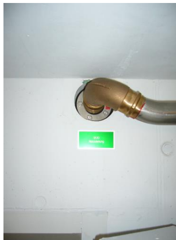
Wasserleitung (Wanddurchführung)
