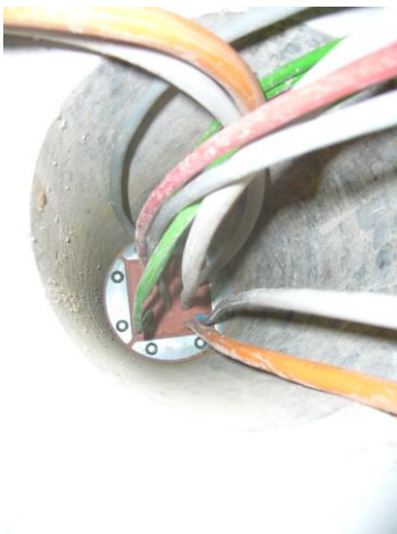
Elektroleitung (Deckendurchführung)
