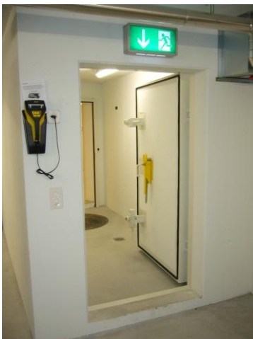
Panzertüre (PT 1) mit betonierter Schwelle
