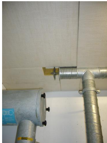
Decken-Isolation, punktgeklebt
