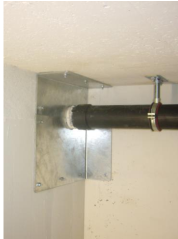
Dachwasserleitung (Wanddurchführung)
