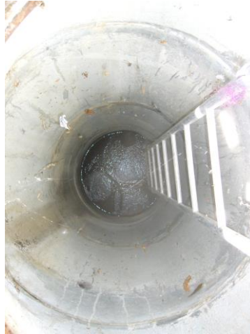
Sickerung mit Bodenablauf
