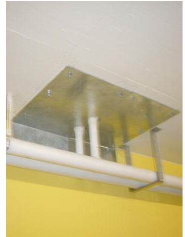
Heizleitung (Deckendurchführung)
