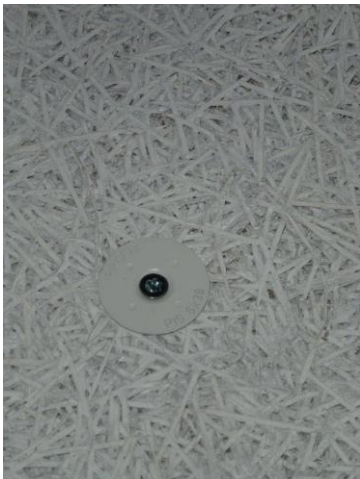
Decken-Isolation, geschraubt
