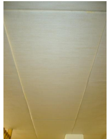
Decken-Isolation, mit einem Schienensystem montiert
