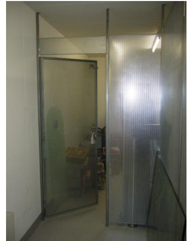
Trennwände aus Lochblech
