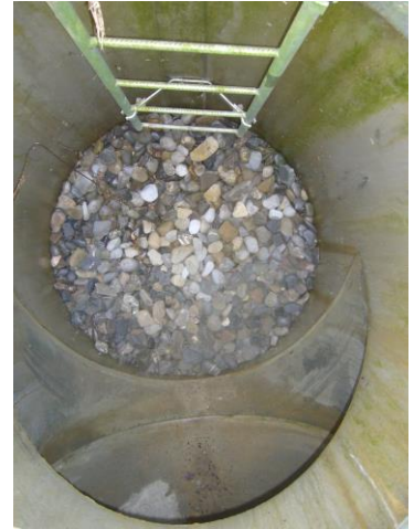
Sickerung mit Schotter/Kies
