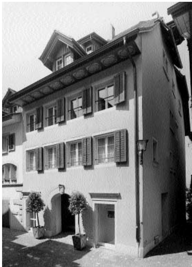
Abb. 4 Die Sust der Stadt Zug, wie sie sich heute präsentiert (Unteraltstadt 20). Der Türsturz trägt die Datierung 1575. Das seit mindestens 1450 nachweisbare Vorgängergebäude befand sich an derselben Stelle.
